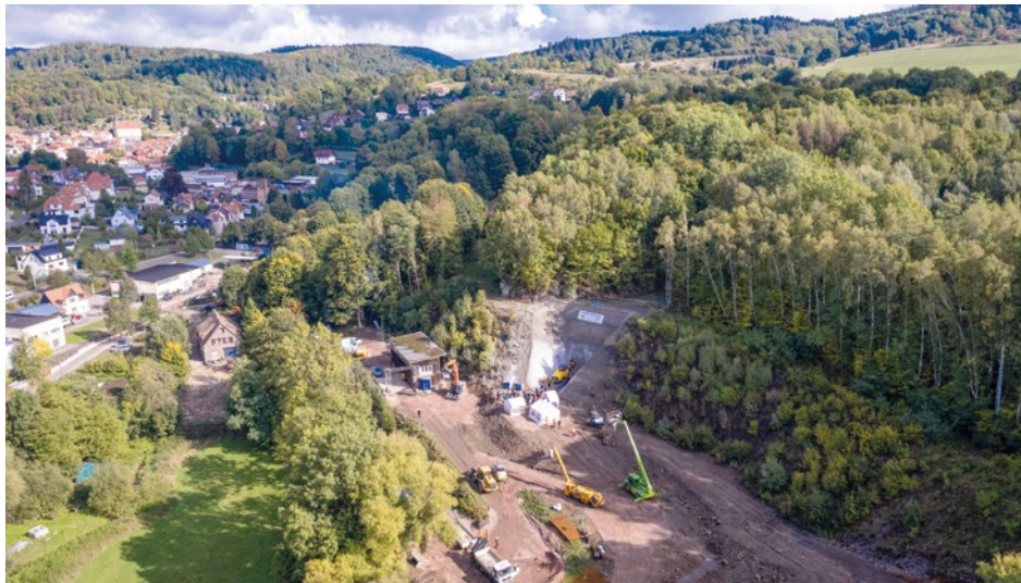
Blick auf den Einschnitt des Anke-Stollens im Bad Liebensteiner Ortsteil Steinbach in Thüringen
