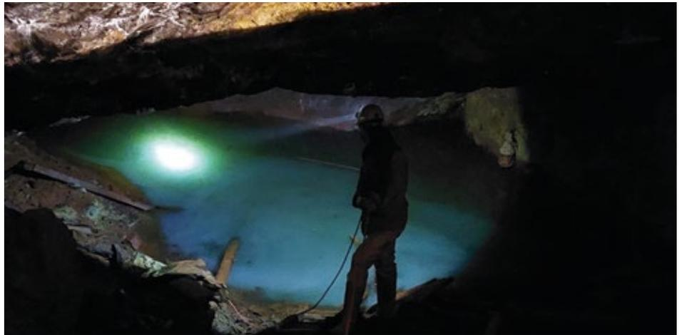
Das dünnflüssige betonartige Material ist nach einer Abbindezeit von 12 Stunden bereits begehrbar.
