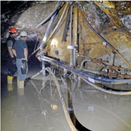
Einbringen des Füllmaterials über ein Schlauchsystem
