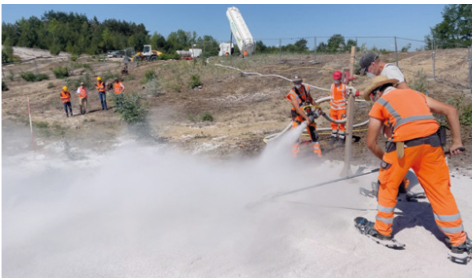
Test zur Perlite-Einbautechnologie mit manueller Steuerung am Versuchsort während der Arbeiten im Juni 2022
