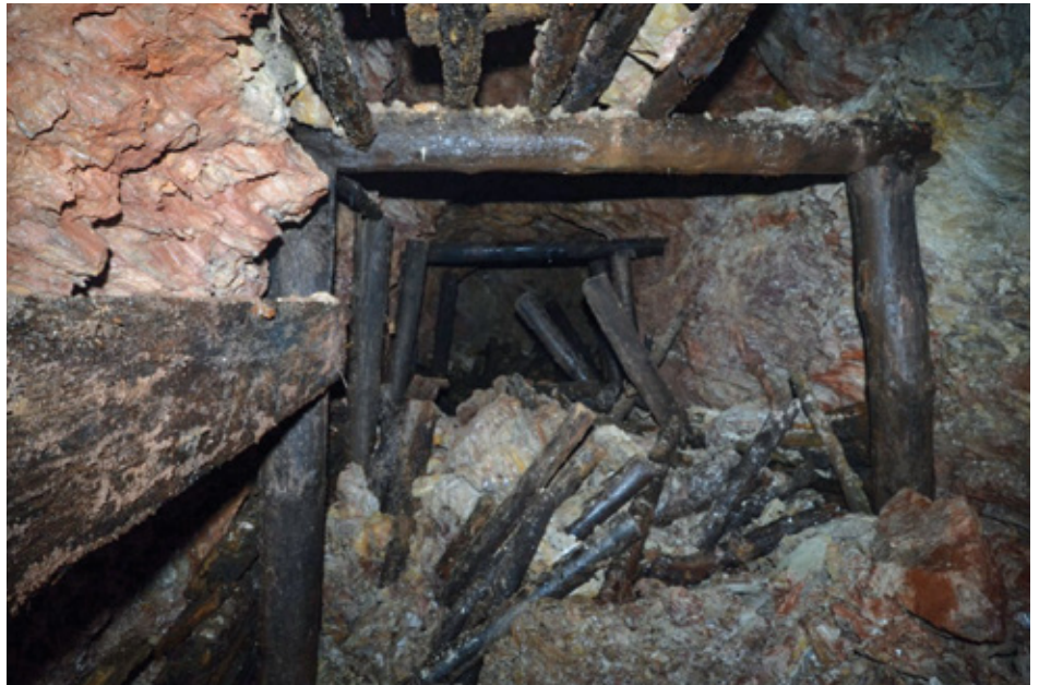
Blick in die eingebrochene Gangstrecke 206 der Schwerspatgrube Brunndöbra
