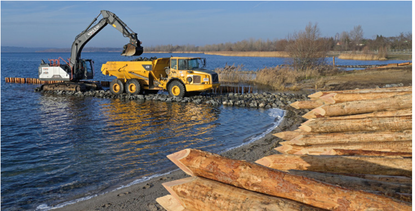
Rückbau eines temporären Steindamms am Franklebener Ufer
