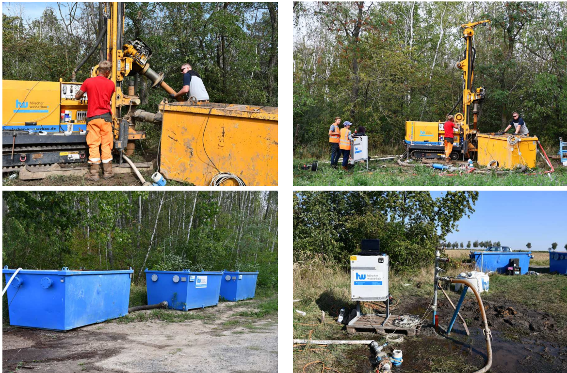
Abbildung 9: Durchführung des Infiltrationsversuches. Durchführung der Bohrung am Standort B (oben), die notwendigen Wassertanks (unten links) sowie die Durchführung des Infiltrationstests selbst am Standort A (unten rechts).
