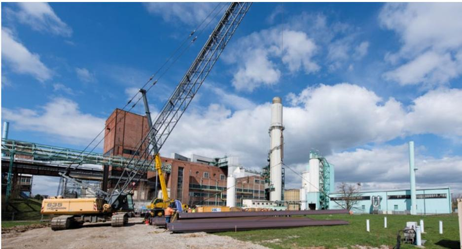
Vorbereitung für das Einpressen der Spundwände am Altstandort der Schwelerei Deuben
