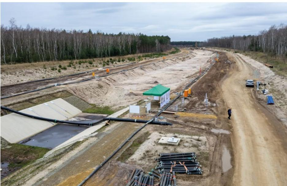
*Die Baustelle des 2.800 Meter langen Ableiters, der künftig die erweiterte Restlochreihe mit der Schwarzen Elster verbindet und an das Gewässernetz anschließt.*
