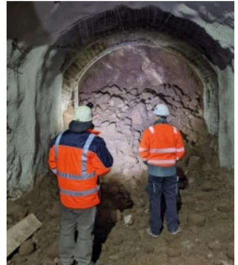
*Nach der Sprengung wird das gelöste Gestein abtransportiert. Im Vordergrund ist das bereits gesicherte Gewölbe des neuen Steinbachstollens zu erkennen.*
