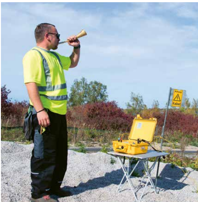
Freigabe der Sprengung zur Schonenden Sprengverdichtung
