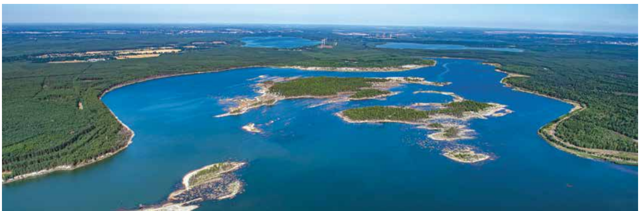
Blick auf das Wasserspeichersystem Lohsa II
