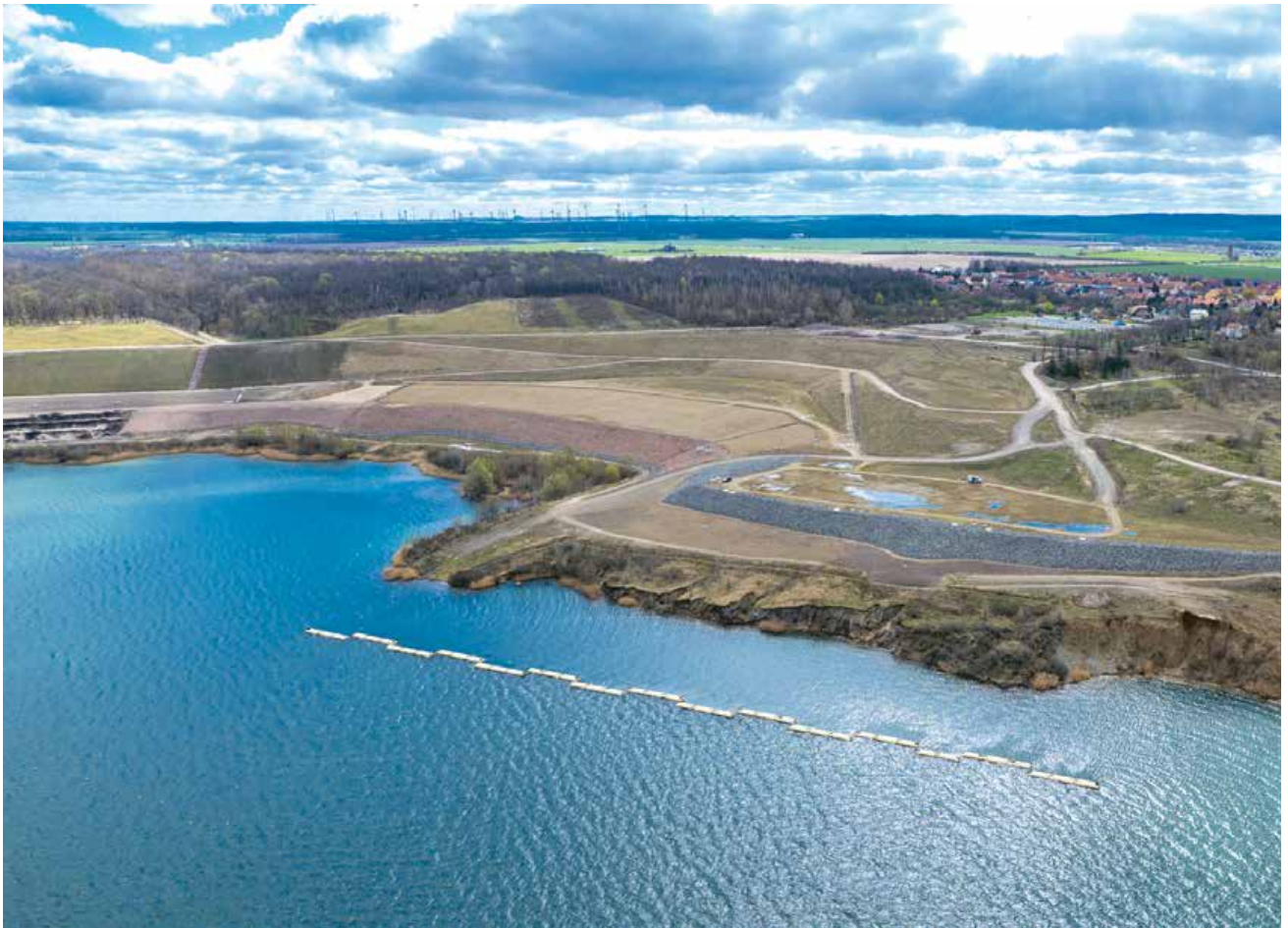
Sanierter Rutschungskessel im Tagebau Nachterstedt
