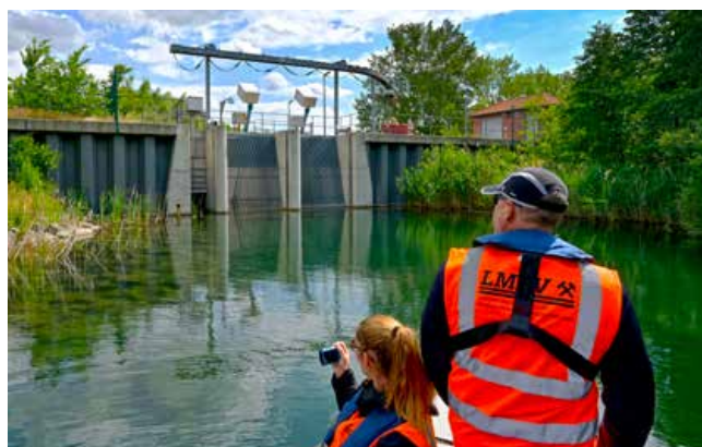
Auslaufbauwerk des Geiseltalsees
