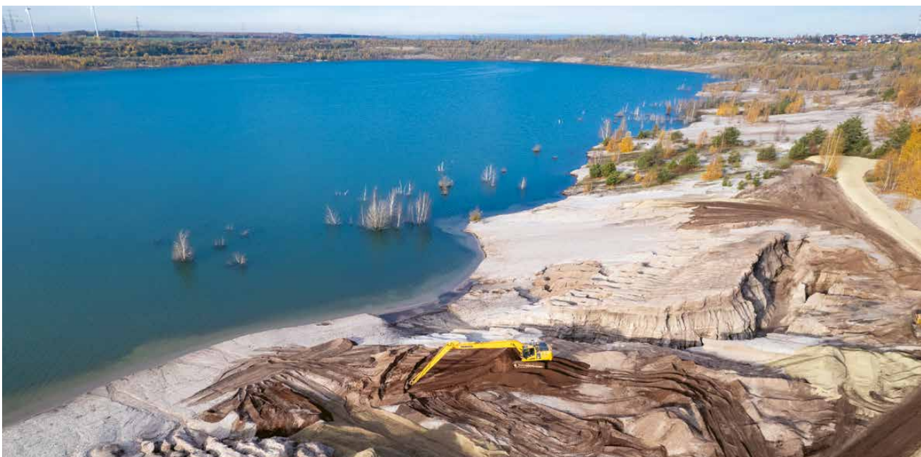
Massenabtrag im Tagebaubereich Wulfersdorf
