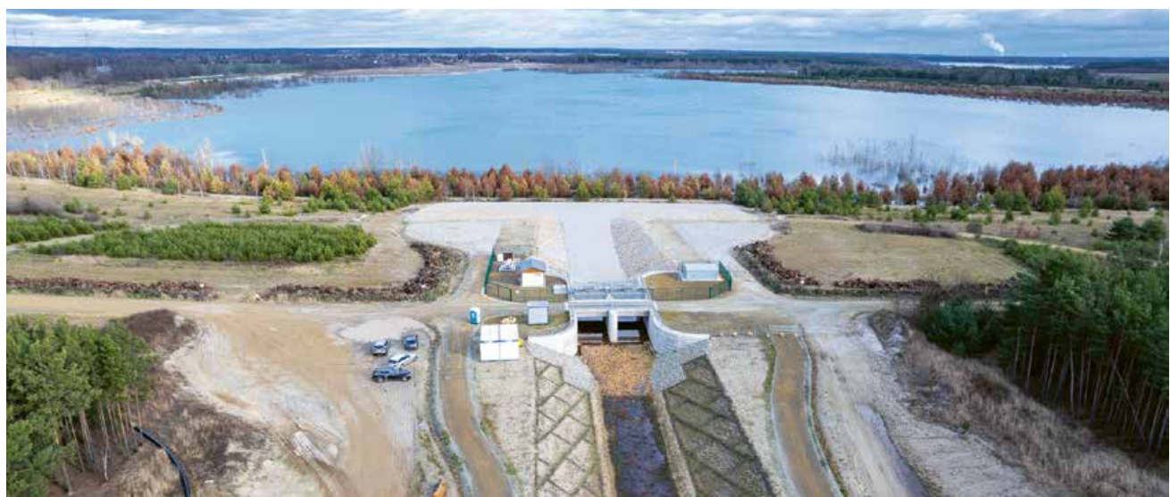
Einlaufbauwerk für den Ableiter aus dem Sedlitzer See
