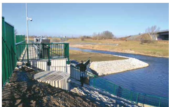
Auslaufbauwerk vom Zwenkauer See in die Weiße Elster
