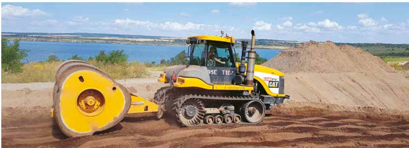
Flächenvorbereitung: Einsatz einer Polygonwalze
