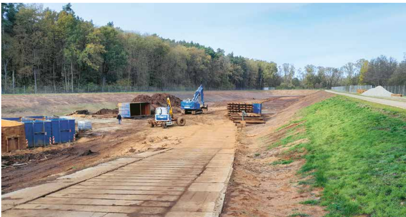
EHS-Beräumung des Sedimentationsbeckens III an der Vorsperre Bühlow
