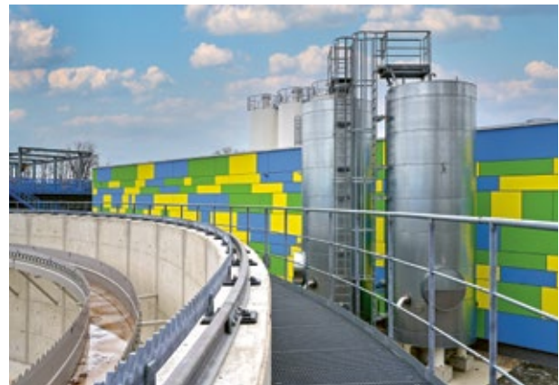
Entfernt das Eisen – die Wasserbehandlungsanlage Plessa
