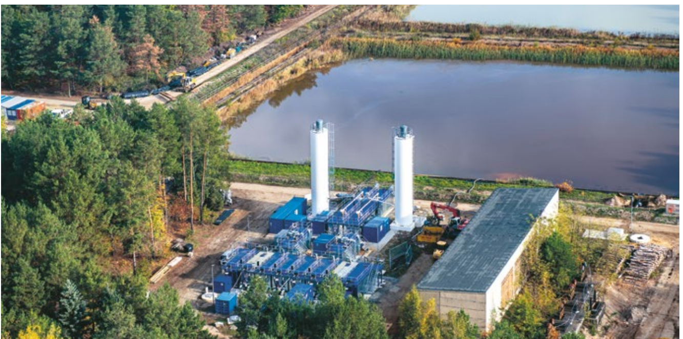
MWBA Burgneudorf an der Kleinen Spree – der EHS setzt sich in den Sedimentationscontainern ab.
