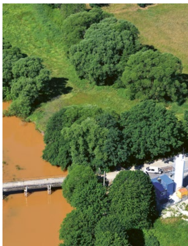
Bekalkungsanlage Spremberg-Wilhelmsthal in Cantdorf
