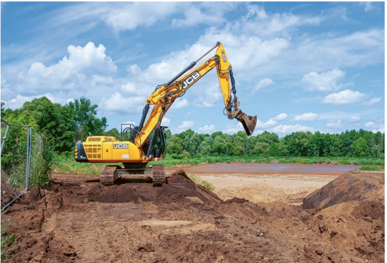
EHS-Beräumung im Sedimentationsbecken der Vorsperre Bühlow
