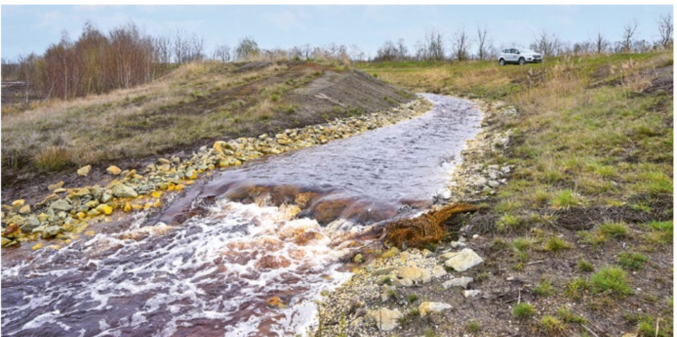
Wasserableiter in der „Kleinen Restlochekette“ bei Lauchhammer
