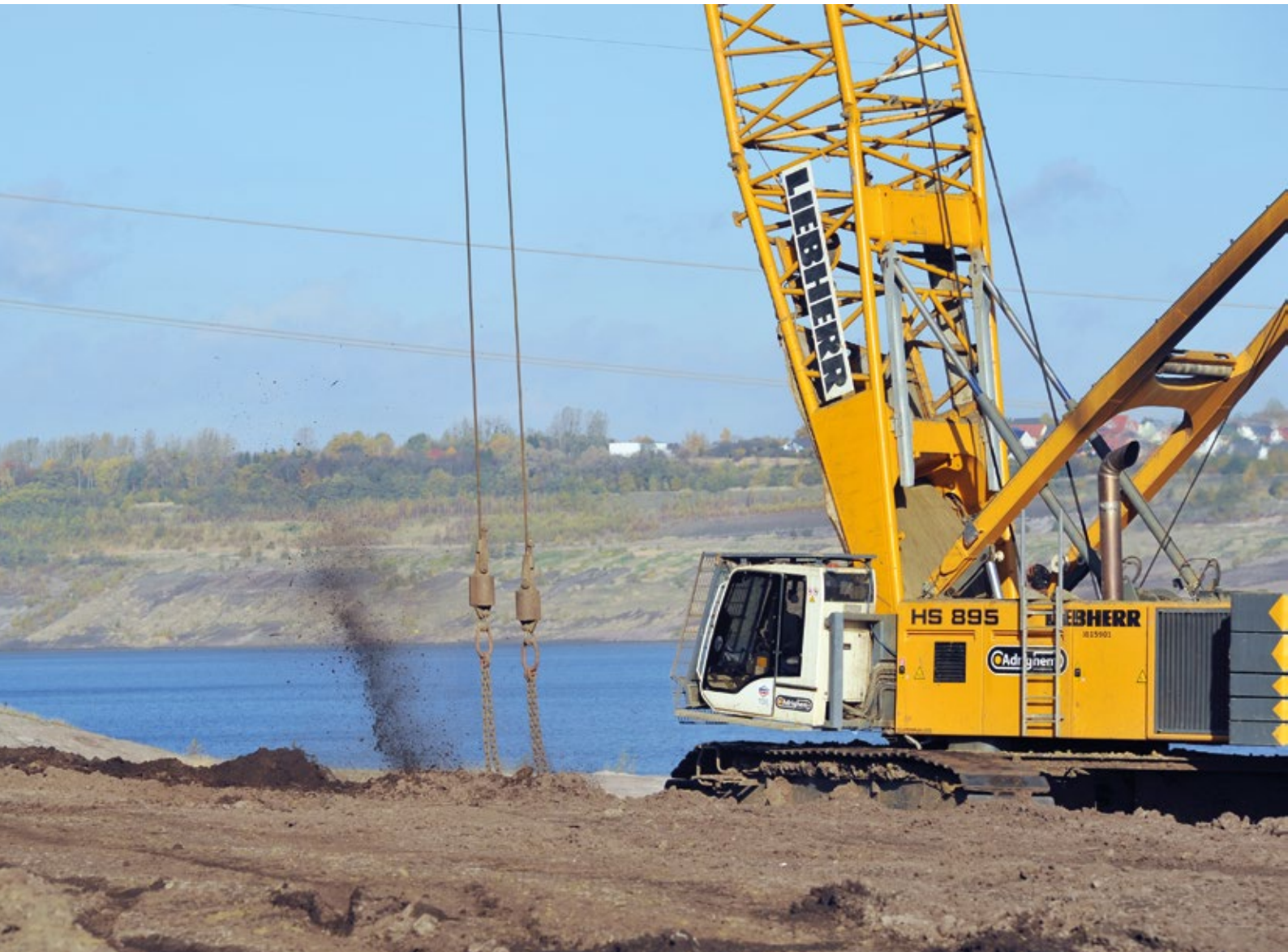
Fallplattenverdichtung am Lappwaldsee im ehemaligen Tagebau Wulfersdorf (o.) Verarbeiten im Schacht Bischofferode (u.l.) Barbarakanal (Überleiter 9) zwischen Partwitzer See und Geierswalder See (u.r.)
