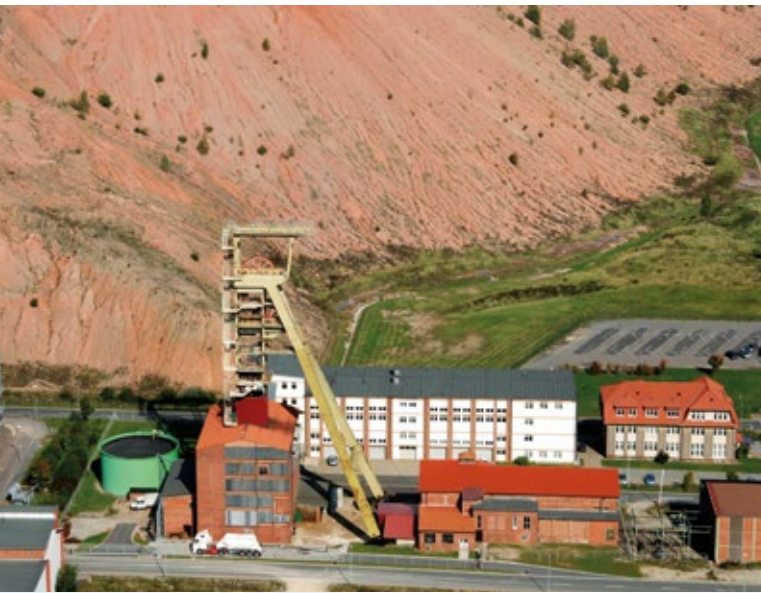
Vormalige Bergwerksanlage Bischofferode (o.l.) Arbeiten im Freieslebenschacht im Mansfelder Revier (o.r.) Damm der Industriellen Absetzanlage Bielatal (u.l.) Kalihalde Bischofferode (m.r.) Kontrollarbeiten in einem Schacht des Bergwerks Wettelrode (u.r.)
