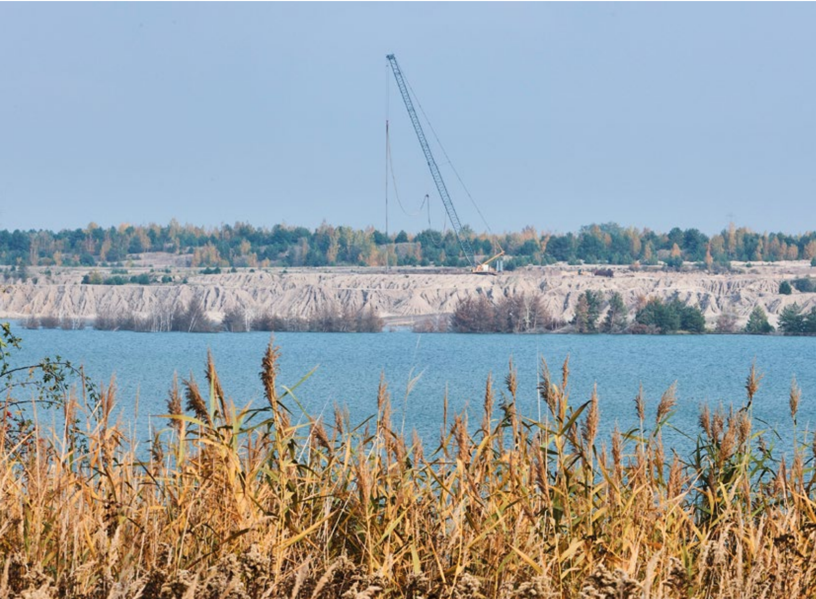
Rütteldruckverdichtung im Innenkippenbereich des ehemaligen Tagebaus Greifenhain (o.) Rüttelstopfverdichtung am Sanierungstagebau Nachterstedt (u.l.) Förster bei der Begutachtung von Jungpflanzen (u.r.)
