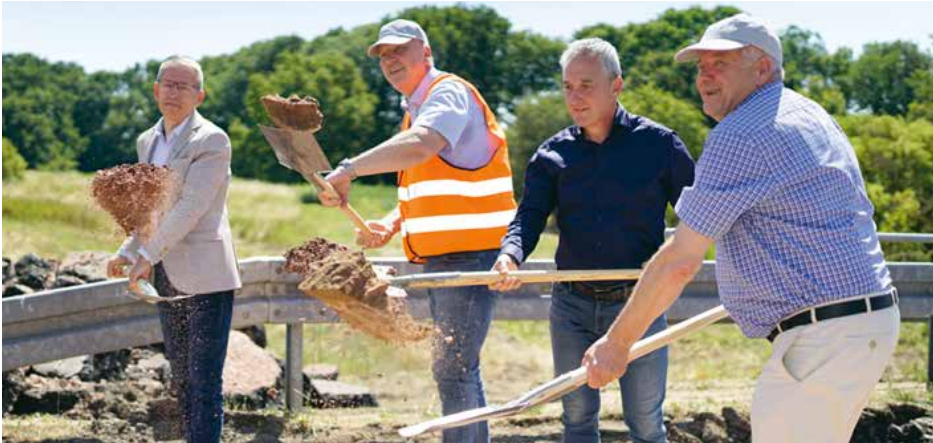
Gemeinsamer Spatenstich für den Ableiter Merseburg-Ost in Luppenau
