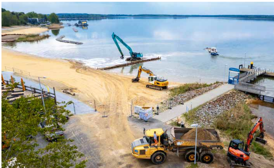
Gestaltungsarbeiten am Ufer des Geierswalder Sees
