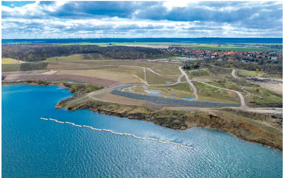
Sanierter Bereich des Haupttrutschungskessels am Concordia See
