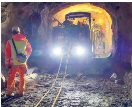
Kontinuierlicher Vortrieb im Stollen: Zuvor Bohren und nachfolgendes Besetzen der Bohrlöcher.
