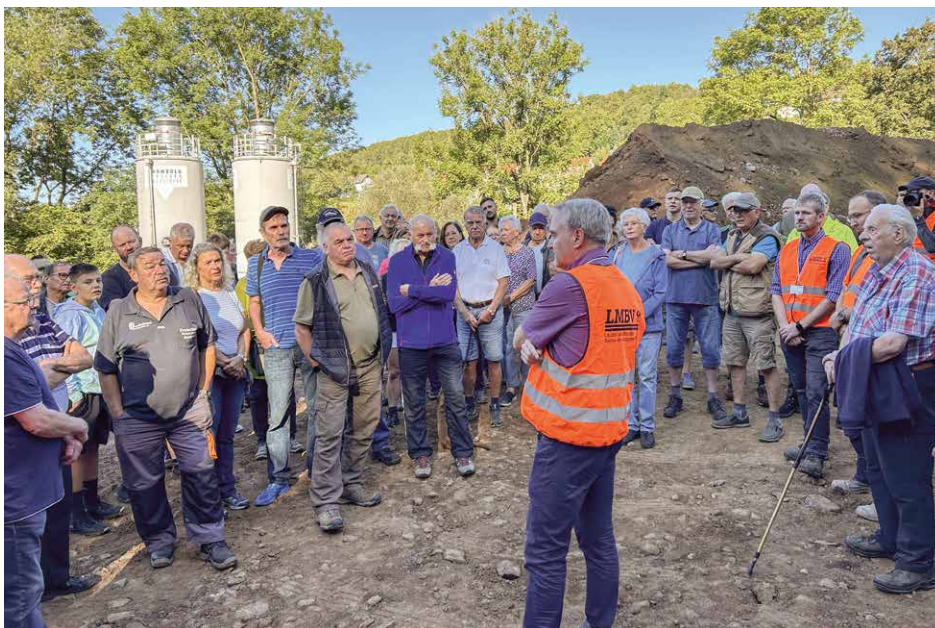
Große Aufmerksamkeit für die Ausführungen von Ralph Haase beim Baustellen-Infotag
