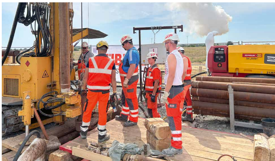
Anspruchsvolles Bohren am Bohrpunkt 1 auf einer verdichteten Kippenfläche im Tagebau Seese-Ost
