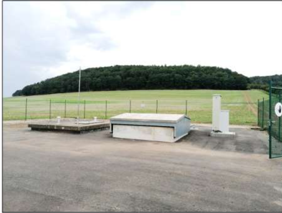
Bohrkeller (links), Übergabeschacht (rechts)
