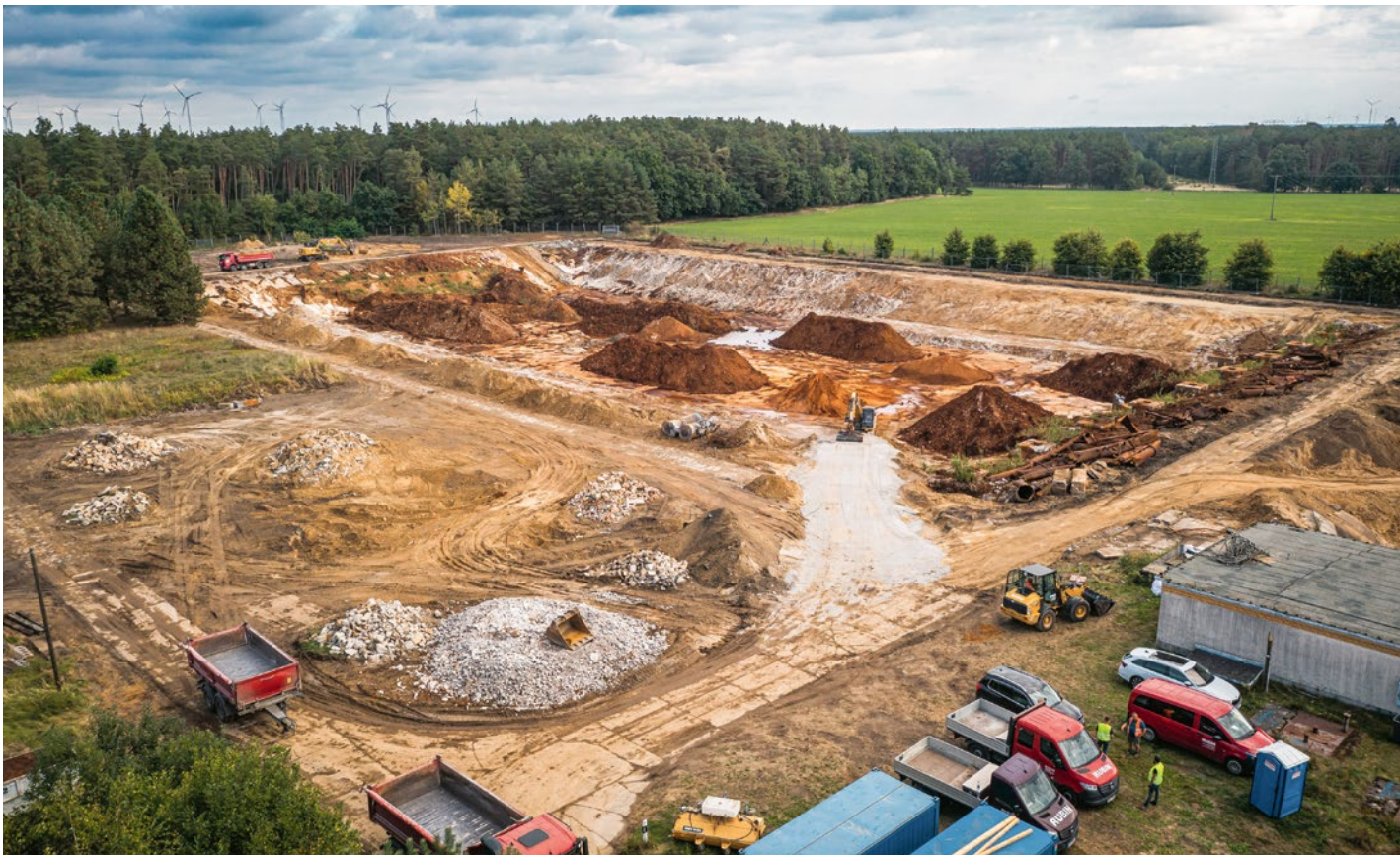
Der Rückbau der vormaligen Grubenwasserreinigungsanlage Lichterfeld ist bereits weitestgehend erfolgt. Als Bauzeit war das 2. Halbjahr 2023 eingeplant.
