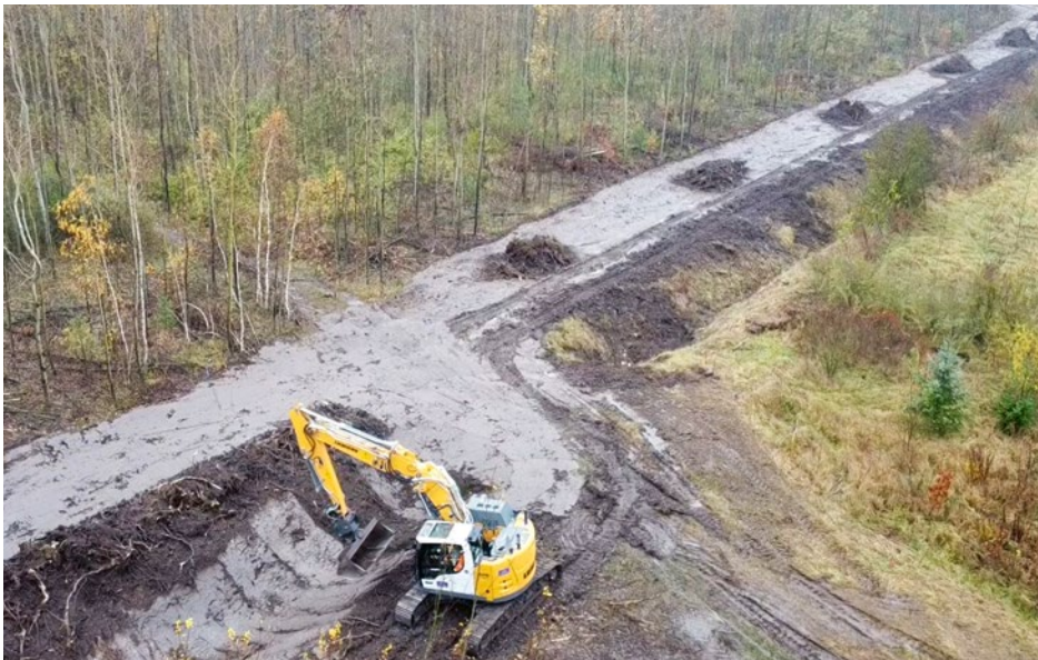
Beginn der Bauarbeiten für die neuen Wege
