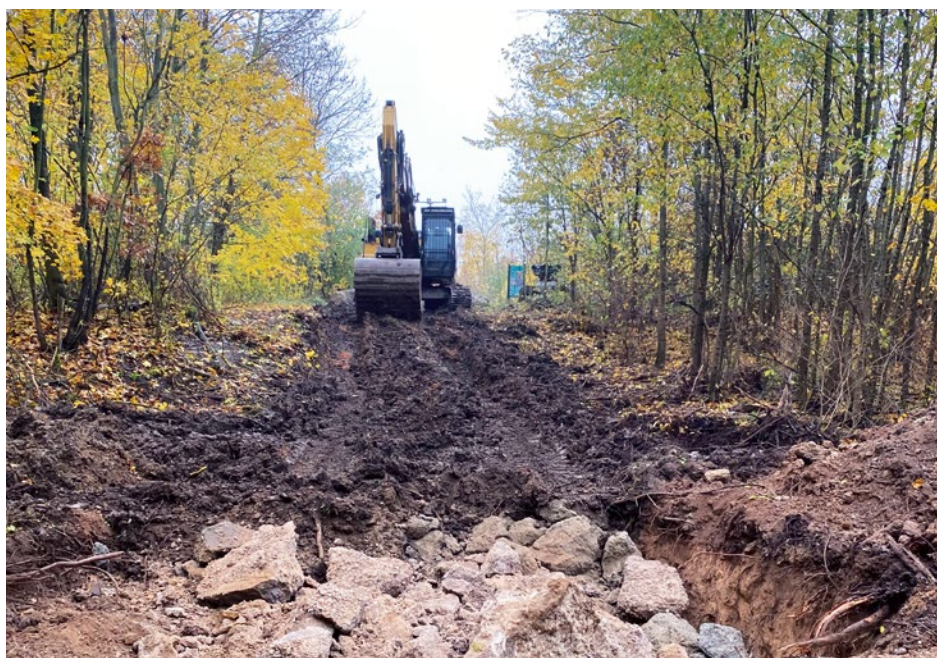
Der Rückbau der Energieverteilungsanlagen am Südwestufer des Zwenkauer Sees kommt voran.
