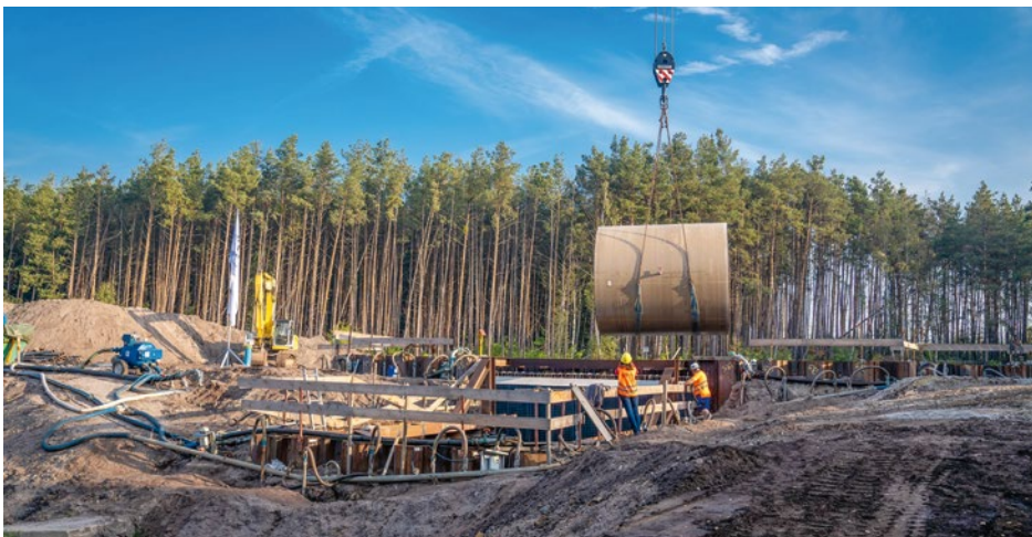
Groß dimensioniert: Einhub des neuen Rohres mit 3,60 m Durchmesser
