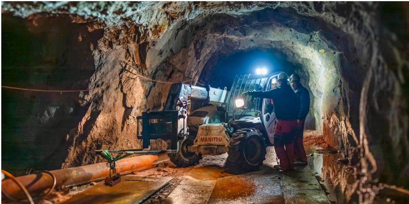
Saigenwartung in Altenberg: Mit schwerem Gerät werden Stahlplatten entfernt, damit die darunterliegenden Pumpensümpfe gereinigt werden konnten.
