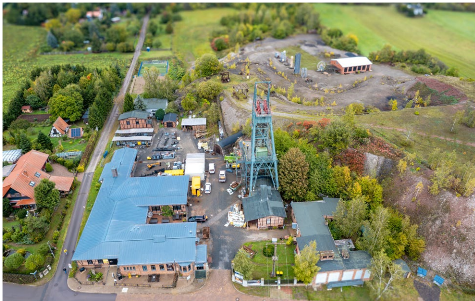
Blick aus der Luft auf die Tagesanlagen des Röhrigschachtes in Wettelrode
