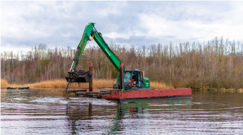
Am Geiseltalseeufer laufen die Brunnenverwahrarbeiten vom Ponton aus.
