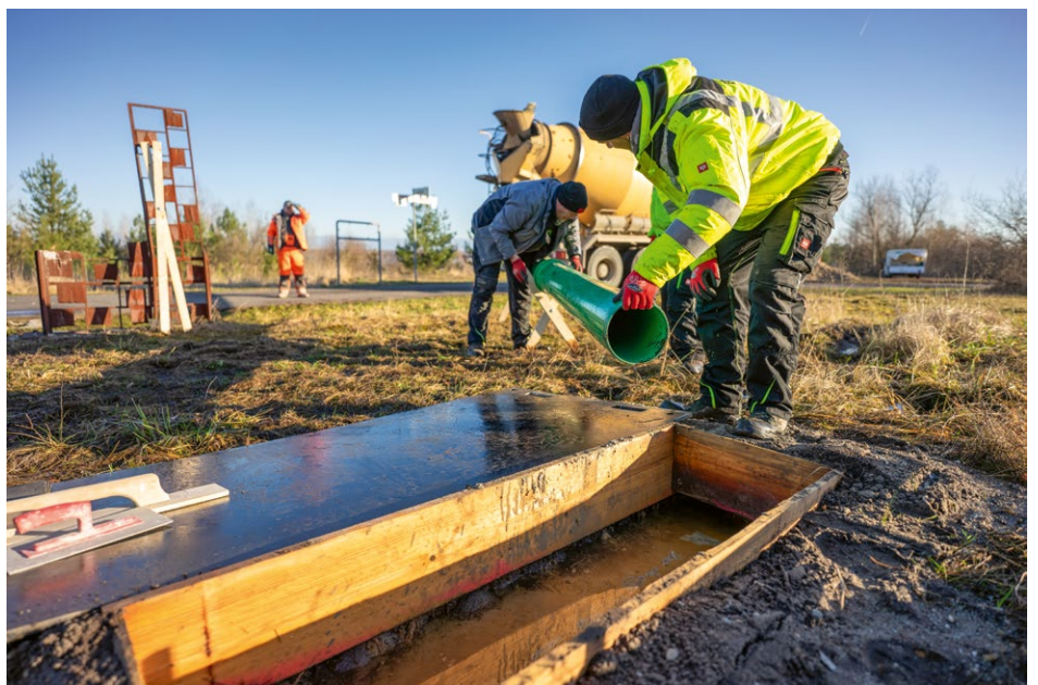
Laufende Arbeiten im Auftrag der LMBV am Gremminer See. Damit der Entwässerungsgraben verbreitert werden kann, müssen einzelne Skulpturen um wenige Meter umziehen.
