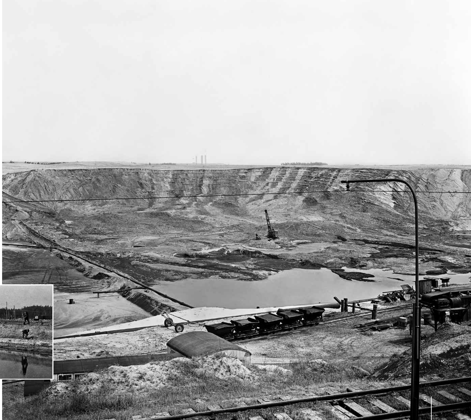
Rutschung im Tagebau Schlabendorf-Nord (Restloch A), 16. Mai 1966
