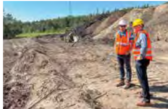
Arbeitsbesprechung zu Sanierungsmaßnahmen am Restloch Greifenhain, 2024
