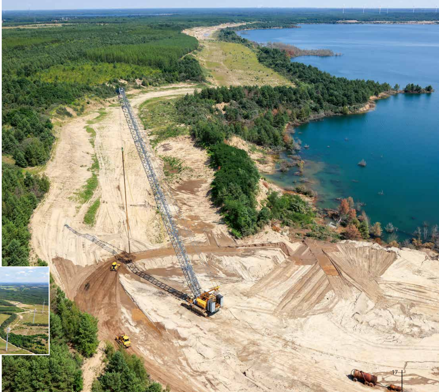
Rütteldruckverdichtung am Restloch Greifenhain, 2024
