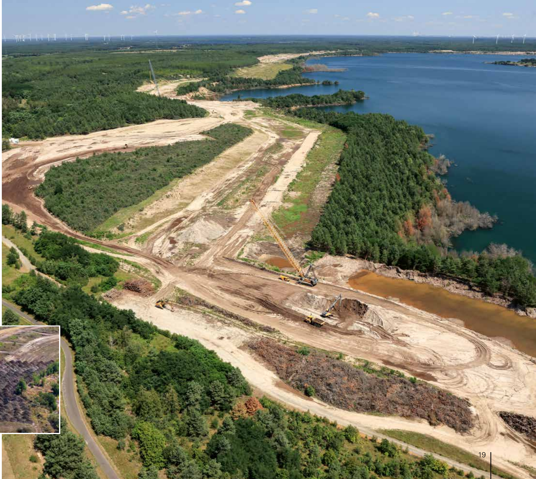
Böschungsprofilierung am Restloch Greifenhain, 2024
