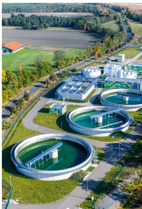
Die Wasserbehandlungsanlage Plessa schützt künftig die Schwarze Elster vor Eisenhydroxidschlamm und Verockerung.
