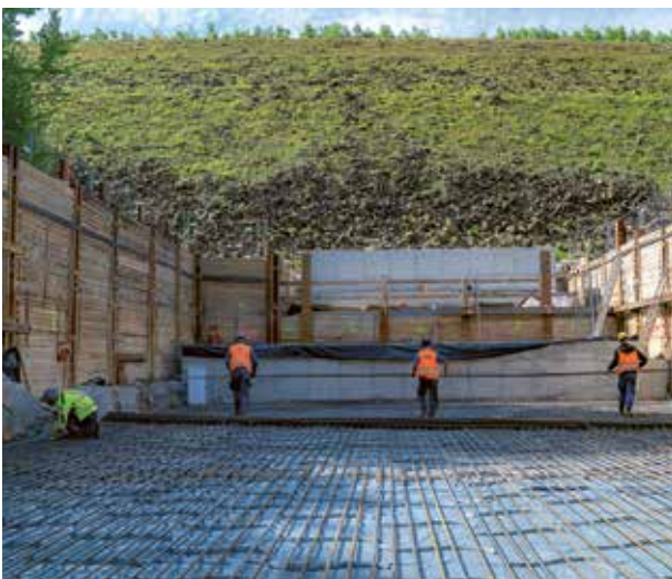
Blick in die Baugrube im Mai 2025
