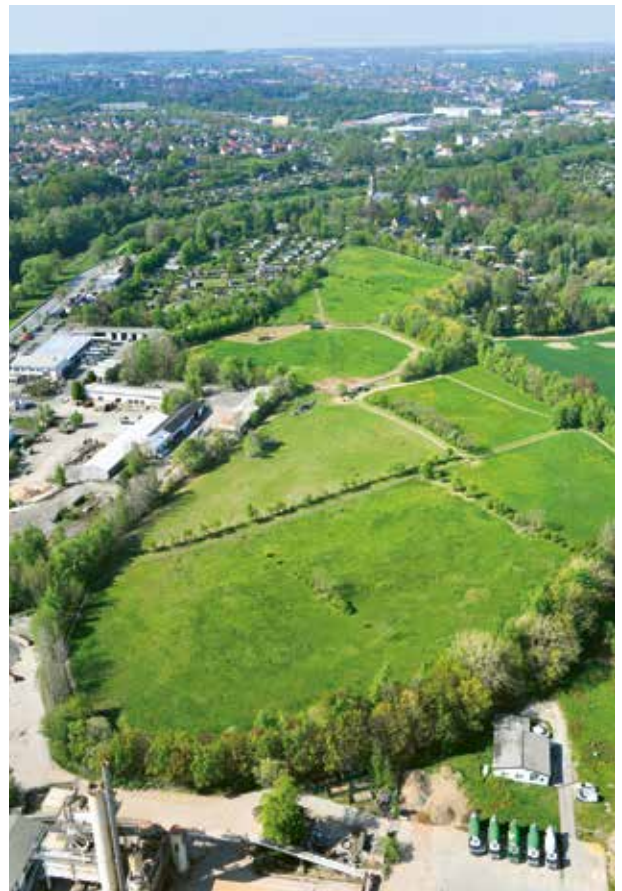
Industrielle Absetzanlage Bockwa
