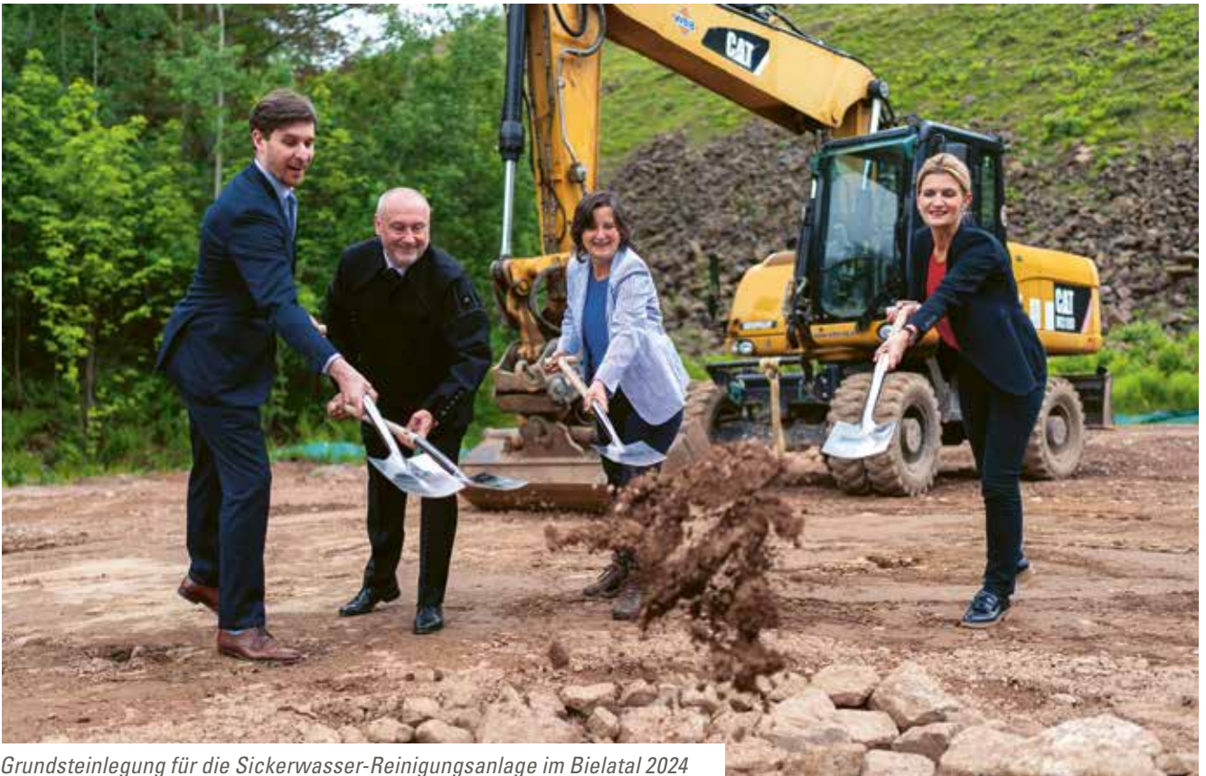
Grundsteinlegung für die Sickerwasser-Reinigungsanlage im Bielatal 2024
