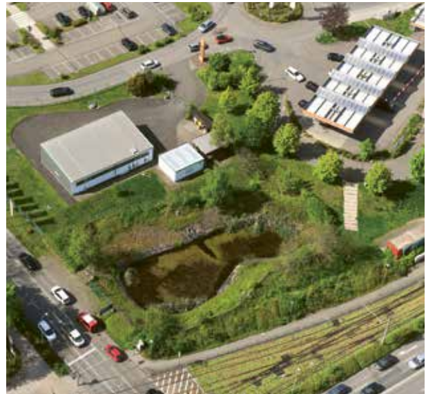
Areal der Grundwasserreinigungsanlage Schedewitz
