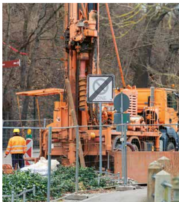
Bohrung am Fuß des Brückenberges
