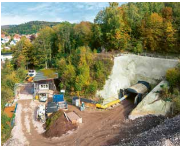
Baustelle des Steinbachstollens im Herbst 2024
