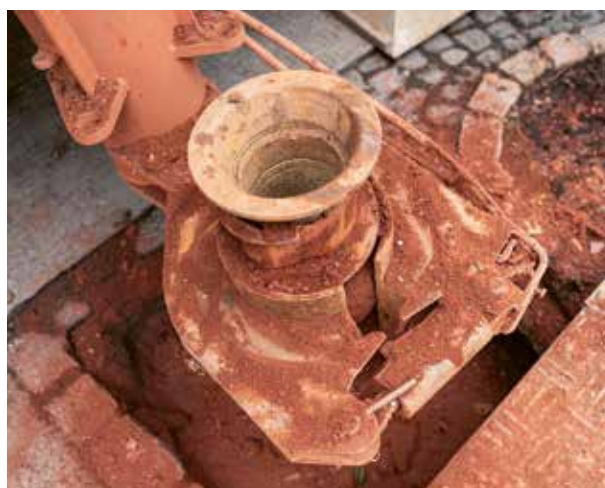
Bohrarbeiten am Brückenberg
