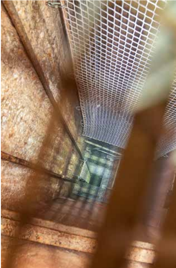
Begehung des Fluchtweges im Schacht
