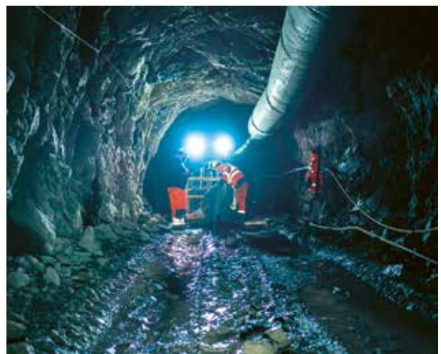
Bauausführung des Steinbachstollens im Herbst 2024
