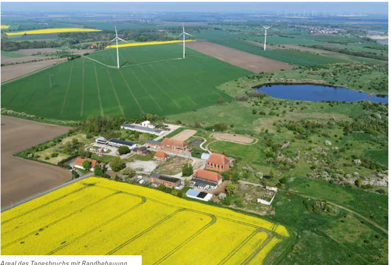
Areal des Tagesbruchs mit Randbebauung
