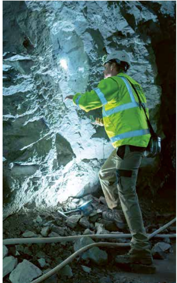
Bauausführung im Steinbachstollen im Herbst 2024
