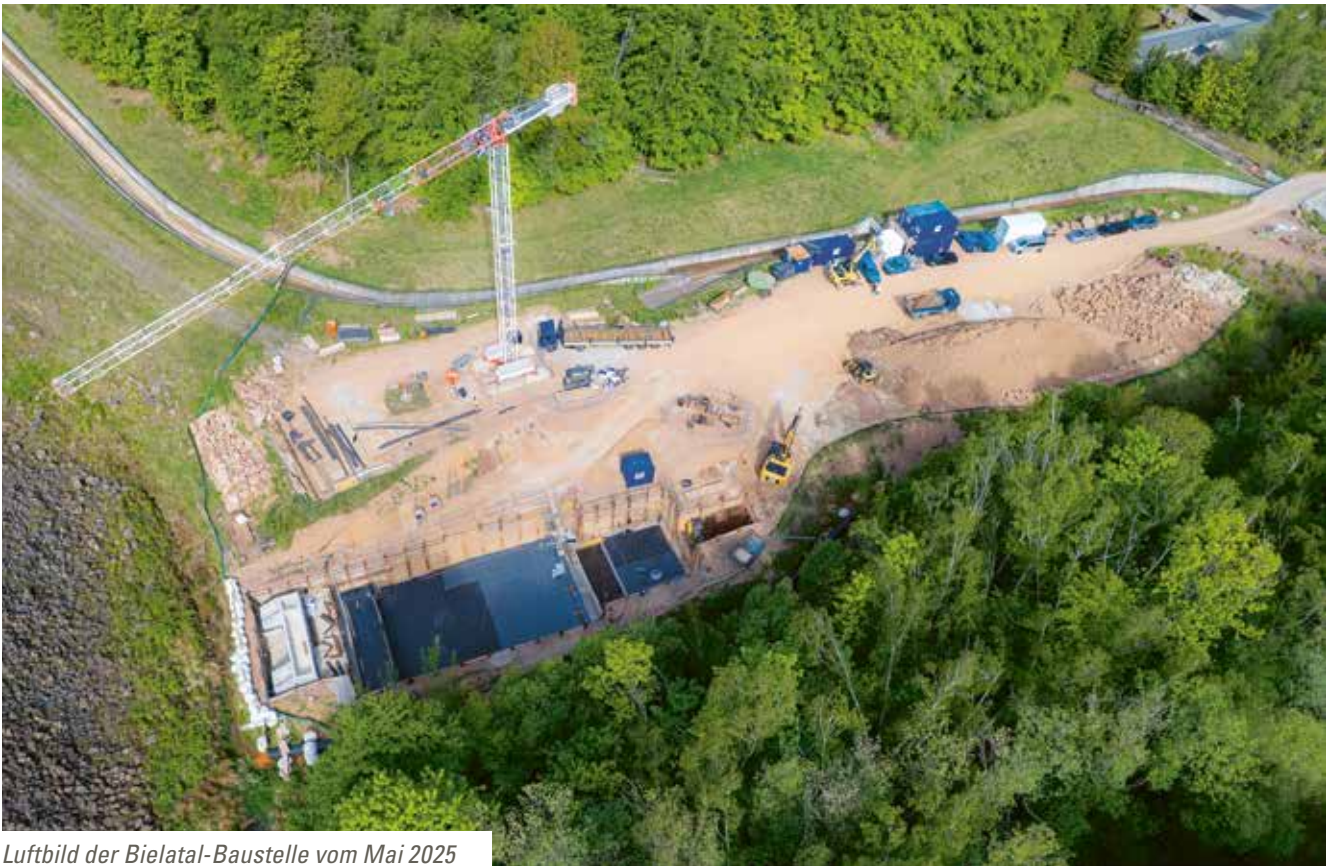
Luftbild der Bielatal-Baustelle vom Mai 2025
