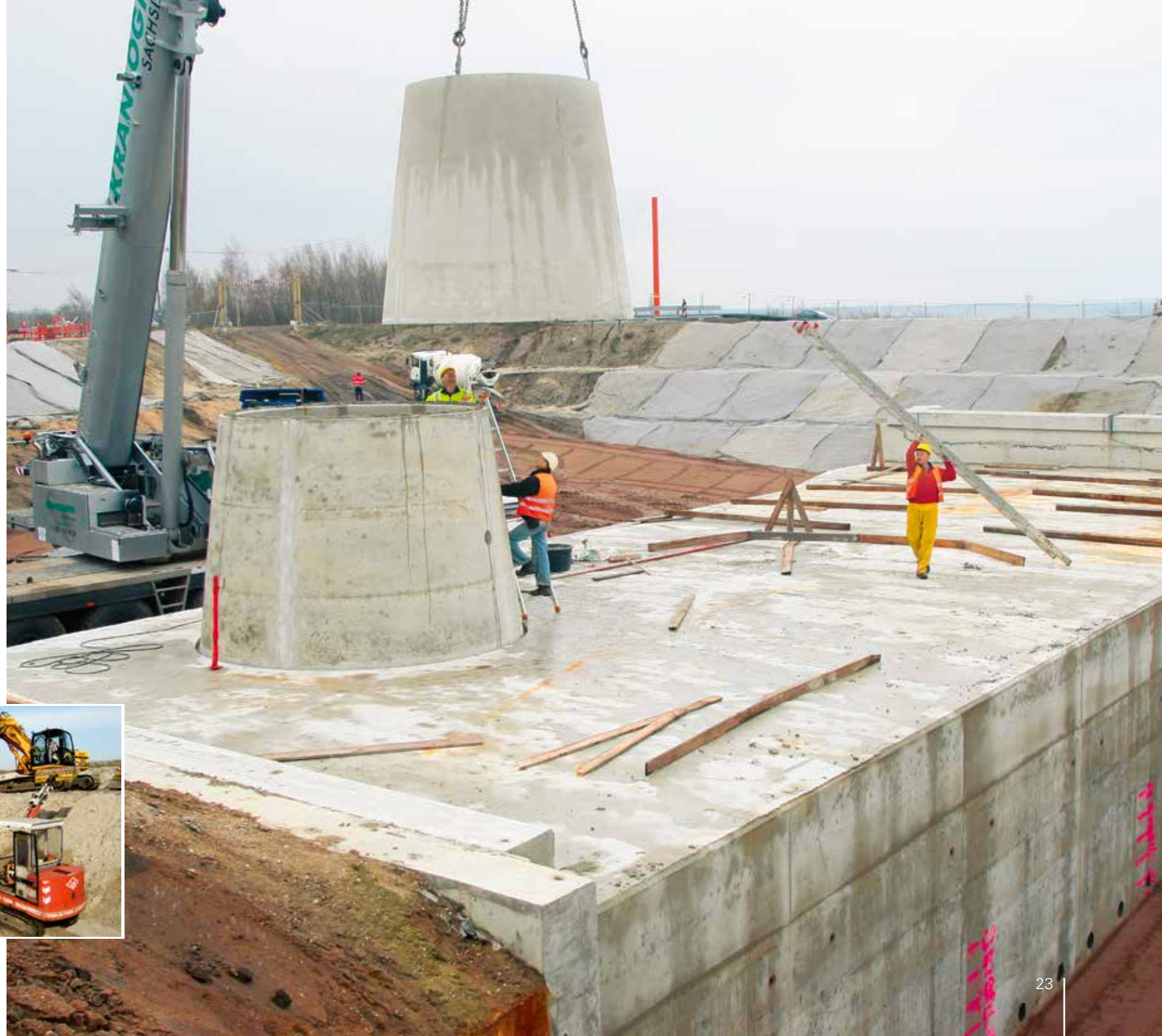
Bau des Überleiters 11 (Ilse Kanal) zwischen Großräschener See und Sedlitzer See, 2012
