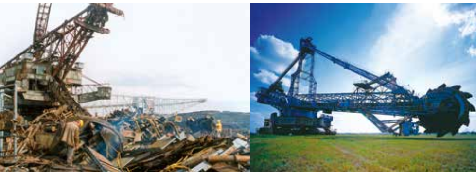
Sprengung des Absetzers A 2 RsB 12.500-1096, 2004 Demontage eines Eimerkettenbaggers, 2000 Schaufelradbagger SRs 1500 als Industriedenkmal am Lausitzring, 2003
