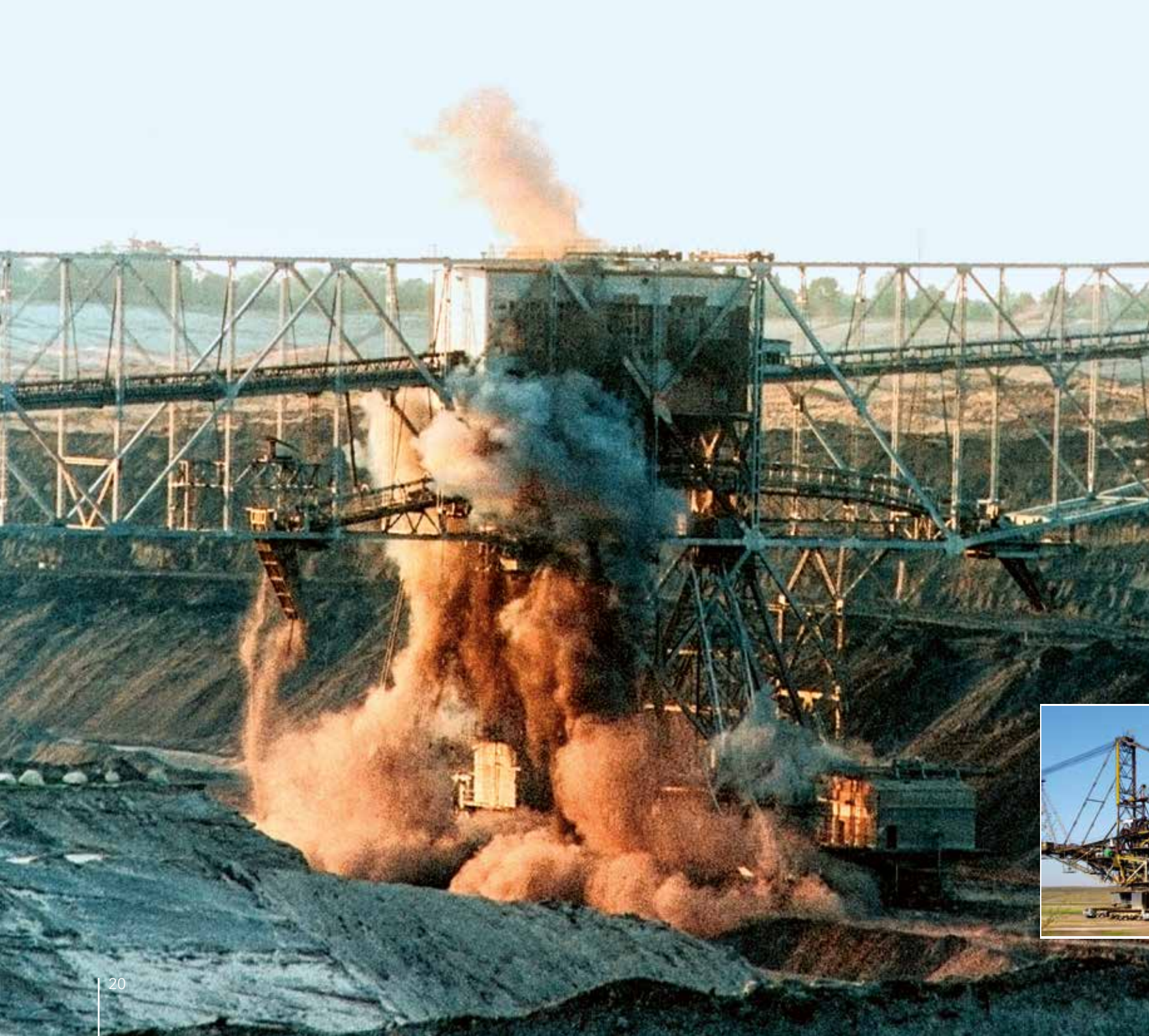
Sprengung der Abraumförderbrücke F 45 im Tagebau Meuro, 2000
