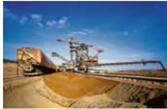
Restlochschließung mit einem Absetzer, 2001
