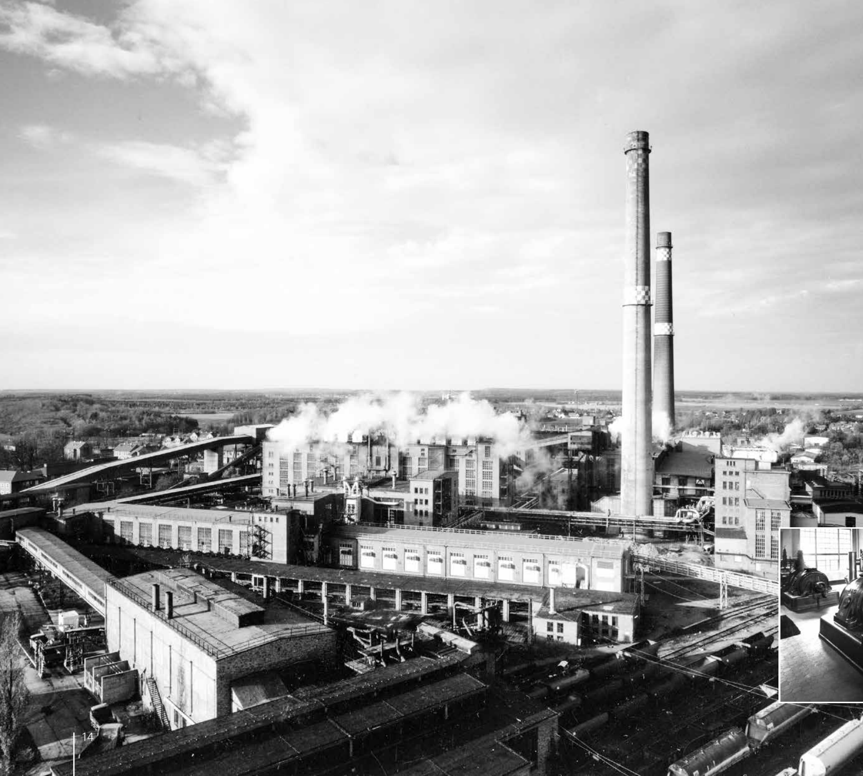
Industriekomplex Sonne mit gleichnamigem Kraftwerk, 1997
