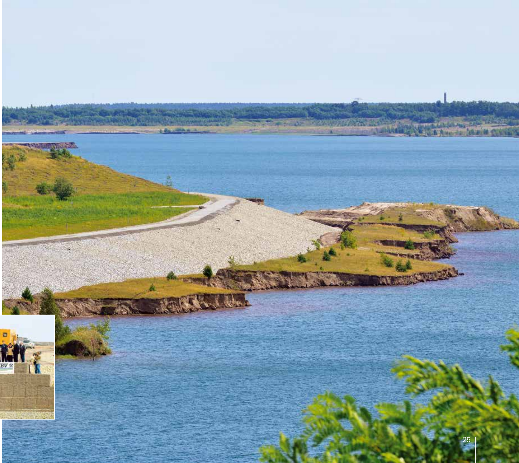
Das Restloch füllt sich zunehmend mit Wasser, 2014
