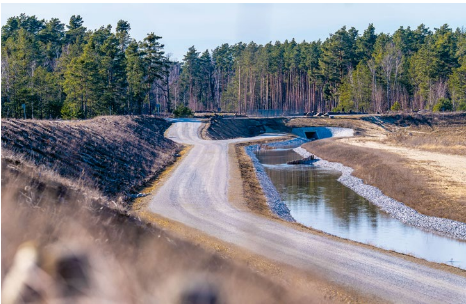
Mit dem neuen Zuleiter verfügt der Klinger See nun über eine funktionsfähige Anlage zur Flutung.
