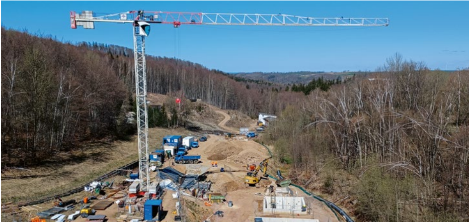
Die Arbeiten an der künftigen Sickerwasser-Reinigungsanlage im Bielatal schreiten voran.
