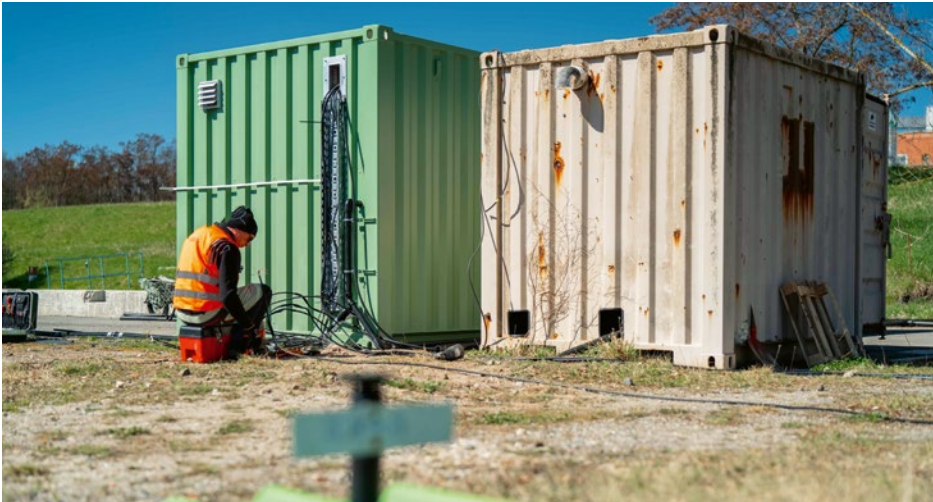
Vorbereitende Arbeiten an der Infiltrationsanlage in Deuben
