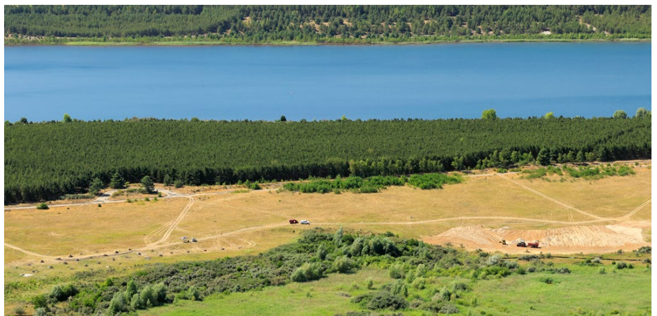
Vorbereitungen für die SSPV im Bereich des Tagebaus Seese-Ost in 2025 (am unteren Bildrand)
