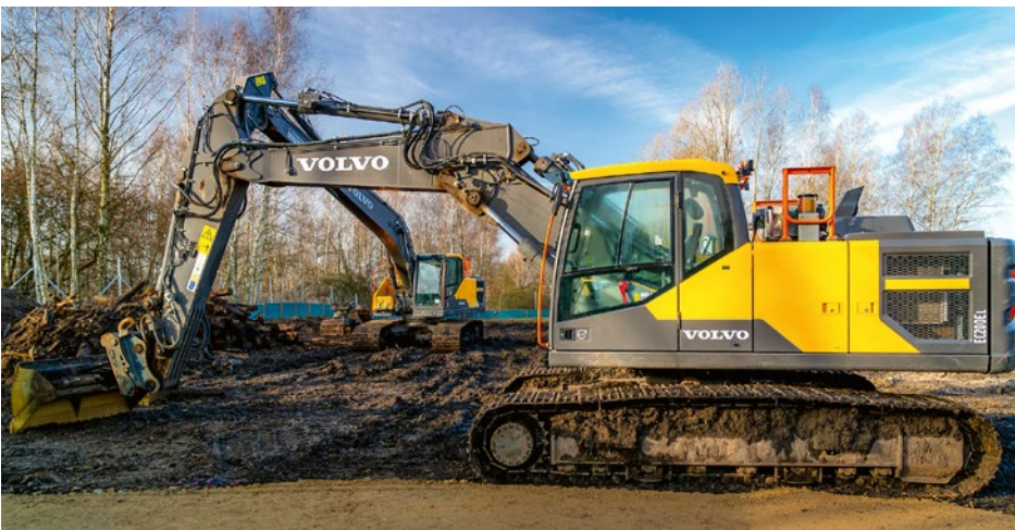
Einsatz von Erdbau-Technik auf der Baustelle
