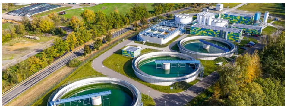
Die Wasserbehandlungsanlage Plessa schützt künftig die Schwarze Elster vor Eisenhydroxidschlamm.
