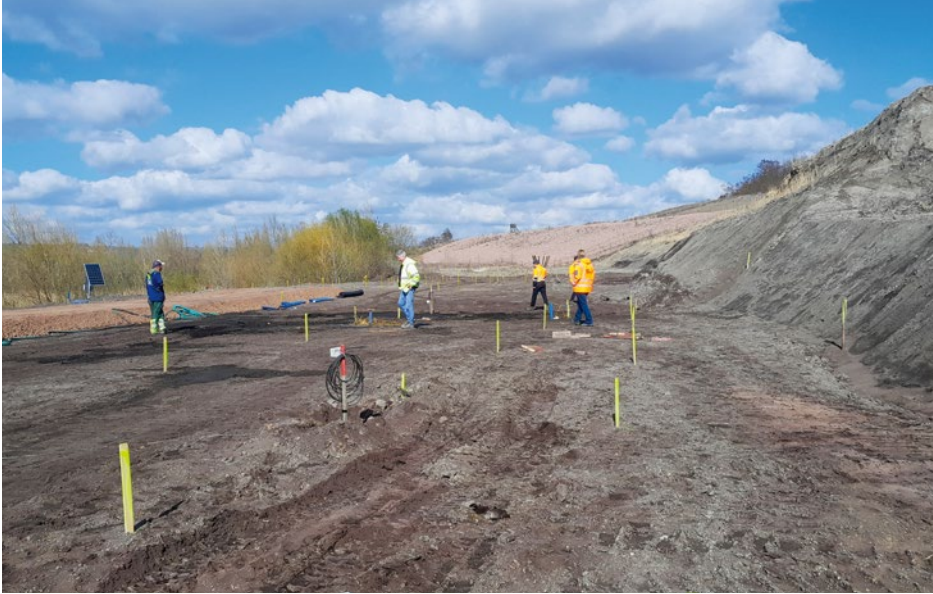
Kontrolle der Bohrlöcher für die Schonende Sprengverdichtung in Nachterstedt
