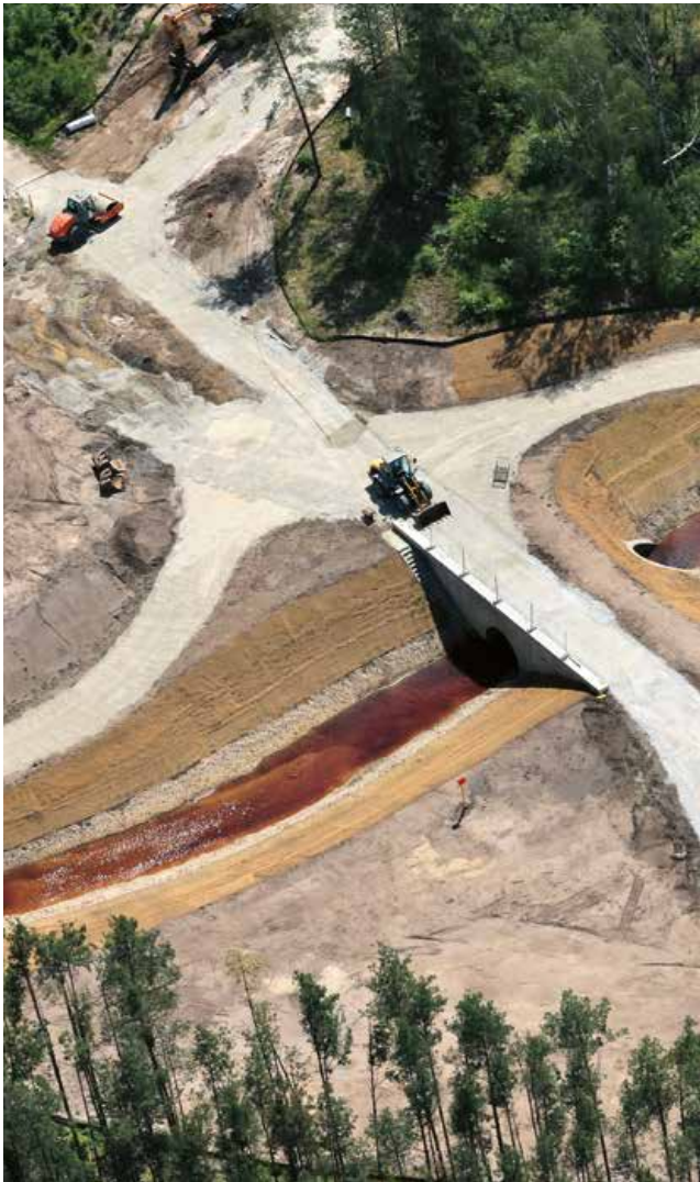
Ersatzneubau des Durchlasses zwischen den Restlöchern 76 und 78
