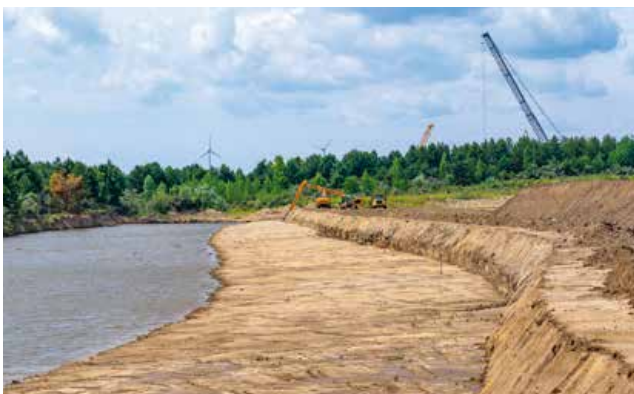
Uferprofilierung am Restloch Greifenhain
