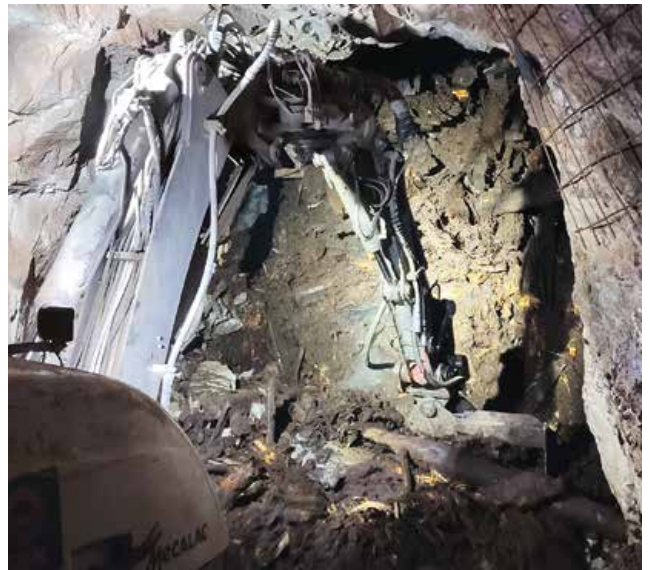
Beräumen von Holzmassen am Füllort des Blindschachtes auf der 60-Meter-Sohle
