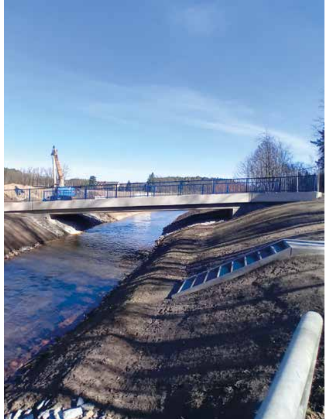
Ersatzneubau der Wirtschaftsbrücke über der Kleinen Spree
