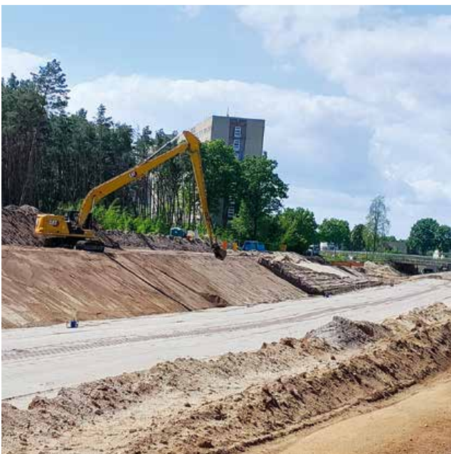
Profilierungsarbeiten am Ableiter Sedlitz
