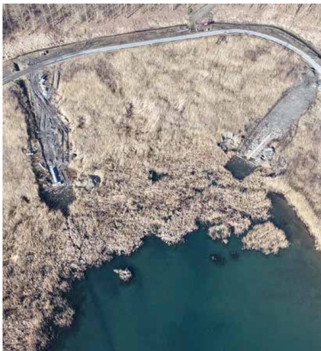
Luftbild vom Bau der Sickerstützscheiben am Berzdorfer See
