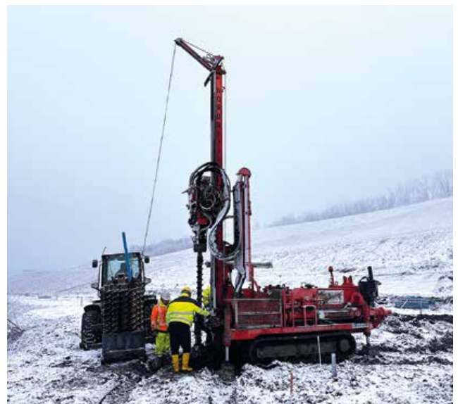
Bohren für die SSPV am Tagebau Nachterstedt
