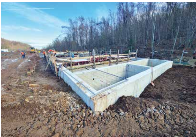
Verfüllarbeiten an der zukünftigen Sickerwasseraufbereitungsanlage an der IAA Bielatal
