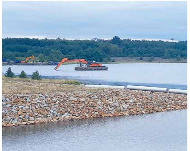
Schwimmbaggerarbeiten auf dem Restloch Sedlitz
