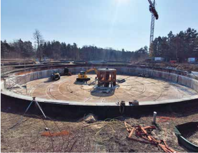
Sanierungsarbeiten an der Grubenwasserreinigungsanlage Pößnitz
