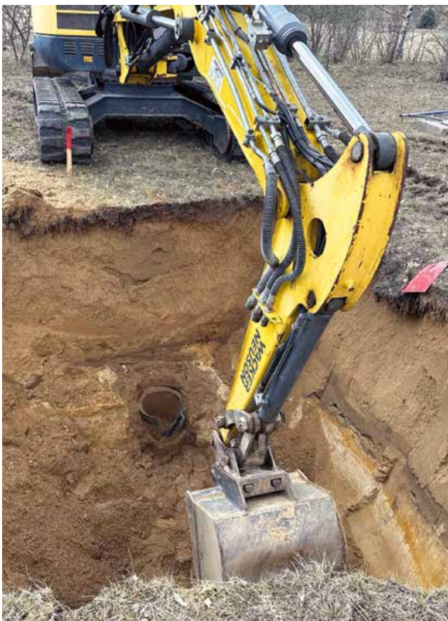
Schürfarbeiten zum Aufsuchen von Filterbrunnen
