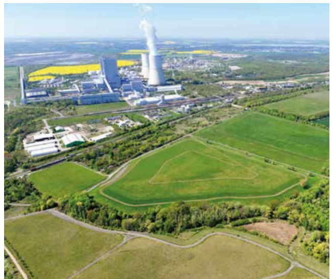
Auflandebecken Gaulis nahe des Kraftwerks Lippendorf
