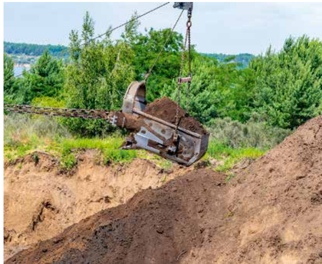
Bodenumlagerung mittels Schürfkübelbagger
