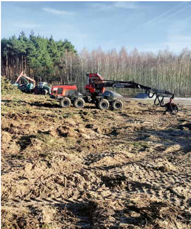
Bauvorbereitende Maßnahmen für die Sanierung der Glassandhalde
