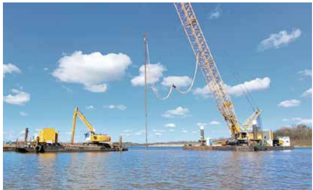
Verdichtungsmaßnahmen am Knappensee
