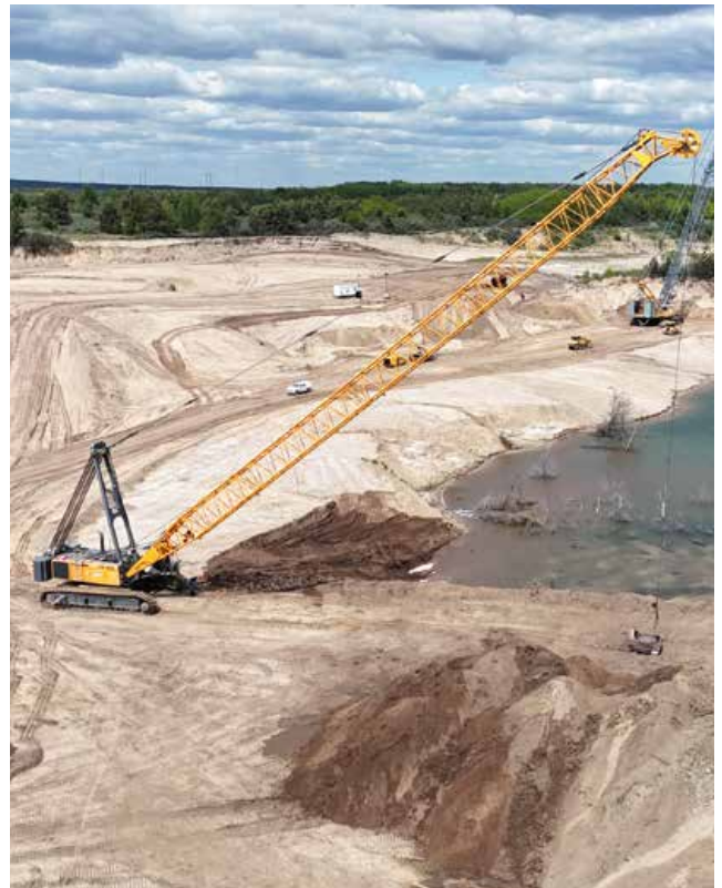
Böschungsprofilierung mittels Schürfkübelbagger
