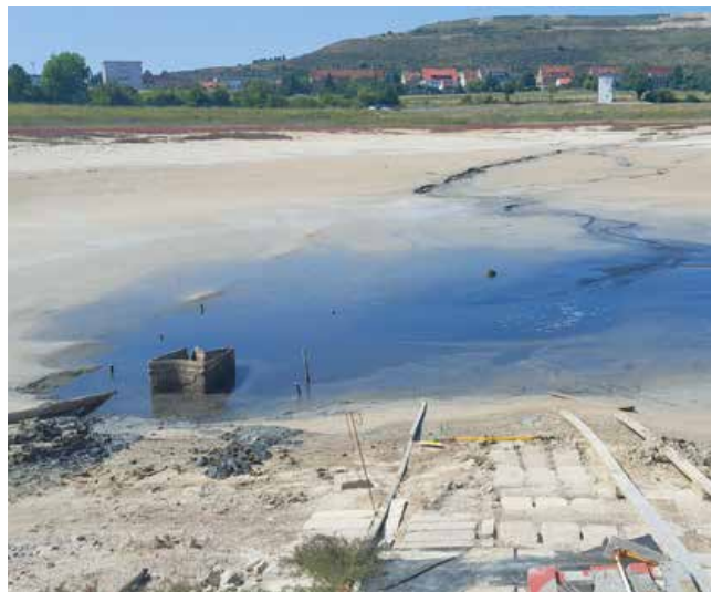
Stapelbecken Menteroda mit abgelagerten Sedimenten
