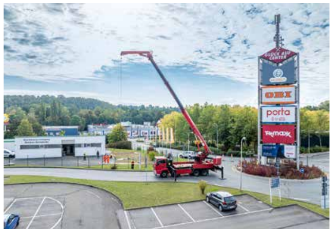
Umbauarbeiten eines Schluckbrunnens in einen Förderbrunnen in Zwickau
