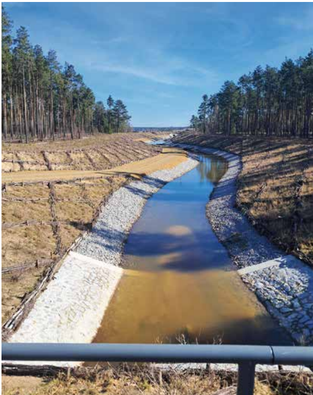
Zuleitungsanlage zum Klinger See
