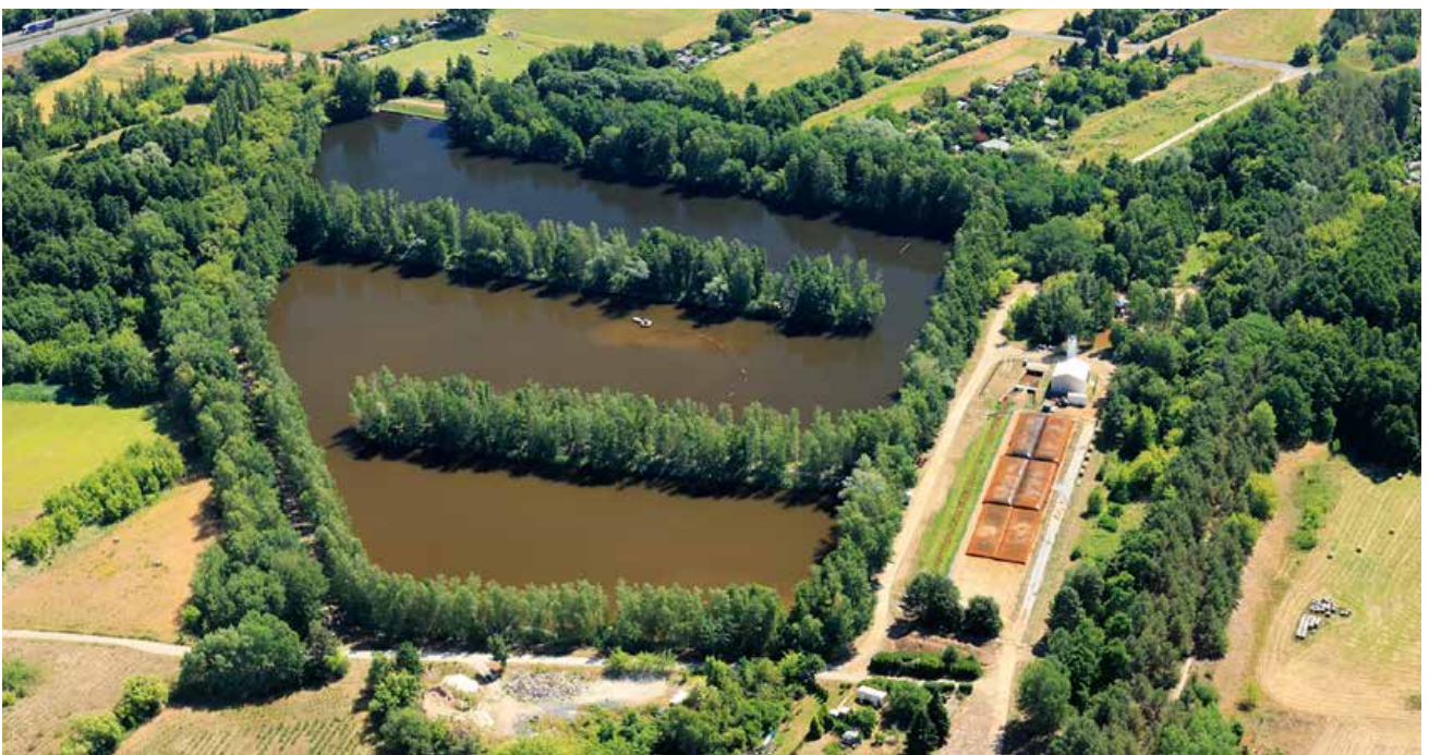
Luftbild der Wasserbehandlungsanlage Vetschau
