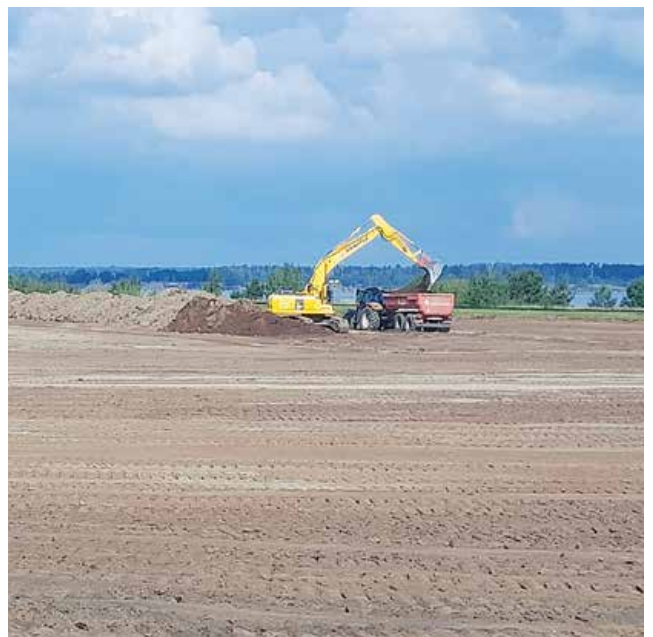
Geländeauffüllung nach erfolgter Sprengverdichtung
