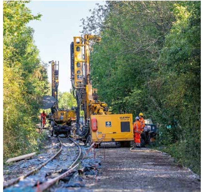
Erkundungsbohrung einer ehemaligen Braunkohlentagebaugrube
