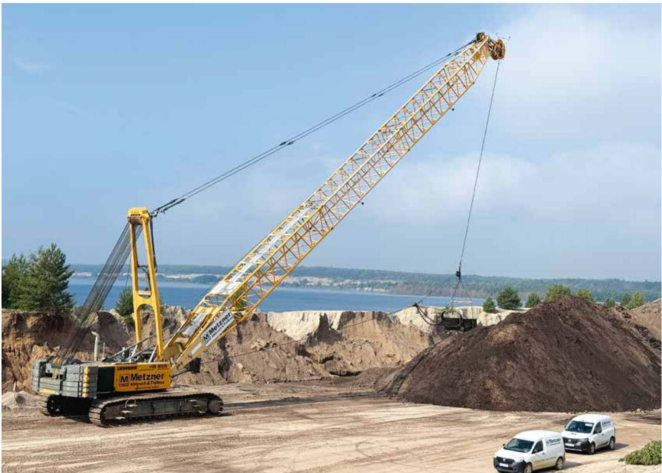
Umweltverträgliche Umsetzung von Sanierungsvorhaben – hier am Restloch Greifenhain
