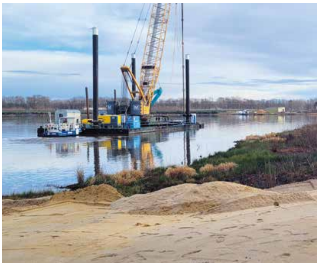
Leichte Rütteldruckverdichtungsarbeiten vom Wasser aus
