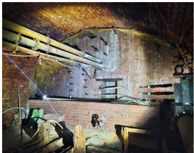
Streckenverschluss im Füllort 1 im Bergwerk Elbingerode
