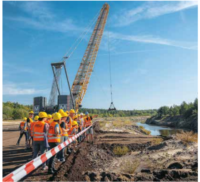
Grosses Interesse beim Baustellentag am Restloch Greifenhain
