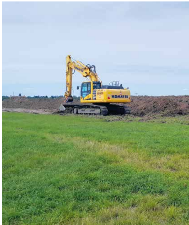
Vorbereitungsarbeiten zur Herstellung des Testfeldes zur SSPV
