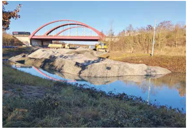
Sicherungsarbeiten am Störmthaler Kanal
