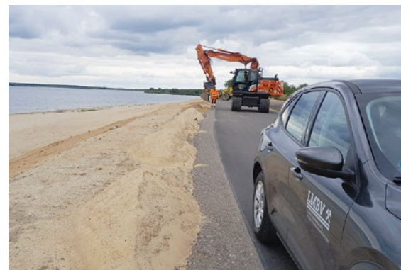
Gestaltung des Strandbereiches und Neutrassierung Wirtschaftsweg am Seelhausener See
