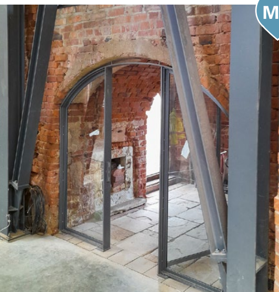
Neu gestaltetes Eingangsportal der Fahrradkirche Zöbiger
