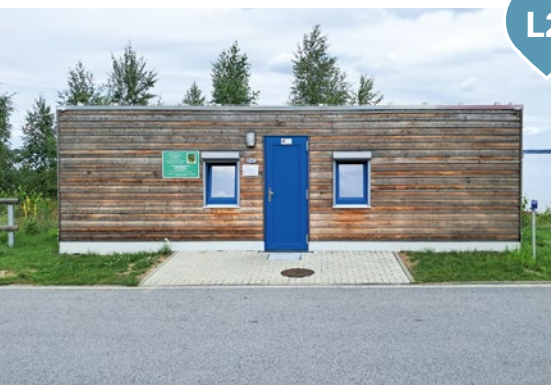
Sanitärgebäude Bärwalder See
