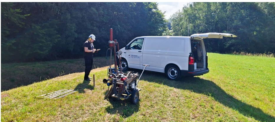
Die ermittelten Kennwerte sollen Auskunft über die Standsicherheit der Randdämme geben.
