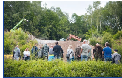
Beim ersten Baustellentag im Juli 2022 nutzten mehr als 120 Besucher die Möglichkeit, sich über das Bauvorhaben zu informieren.
