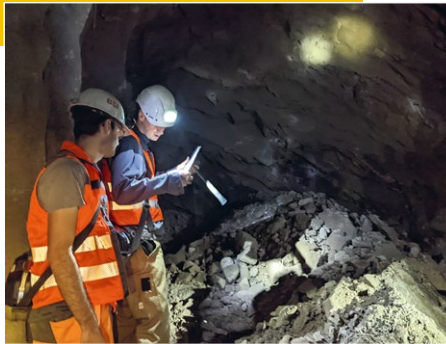
Im Inneren des neuen Steinbachstollens, Juni 2023
