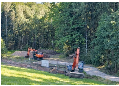
Unterhaltungs- und Sanierungsarbeiten im Umfeld der Industriellen Absetzanlage
