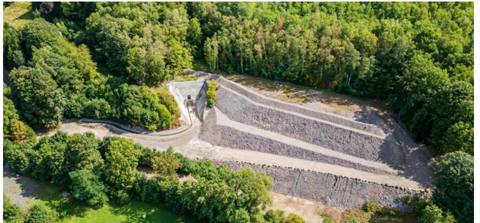
Das neue Stollenmundloch mit der gesicherten Spülhalde am Lindenleitenstein.
