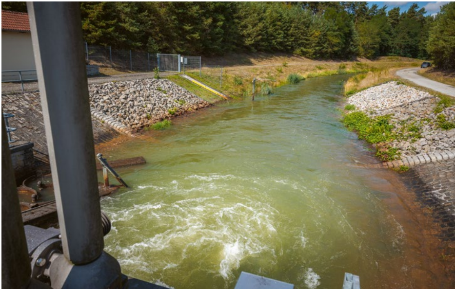
Belastungstest bestätigt Funktionsfähigkeit der ausgebauten Gewässerstrecke Burghammer-Spreewitz
