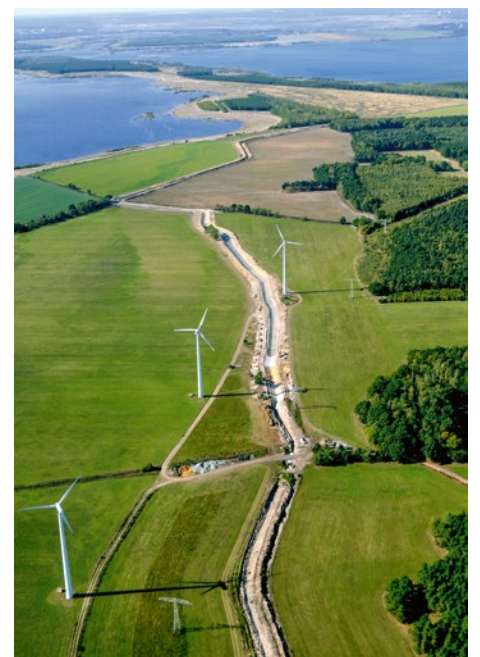
Ausbau des Oberen Landgrabens (Archiv, 2009)
