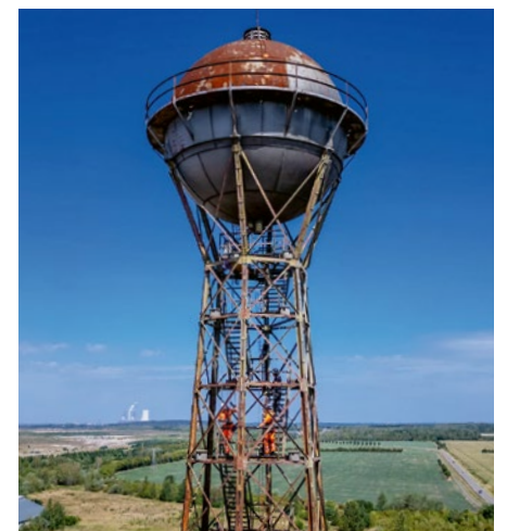
Industriekletterer untersuchten die historische Wasserkugel Deutzen und ihre Stahlkonstruktion.
