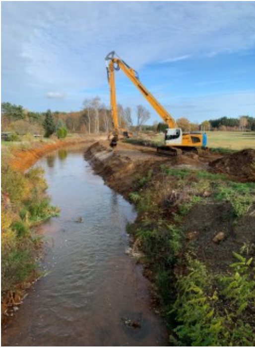
Ausbau der Kleinen Spree in Burgneudorf
