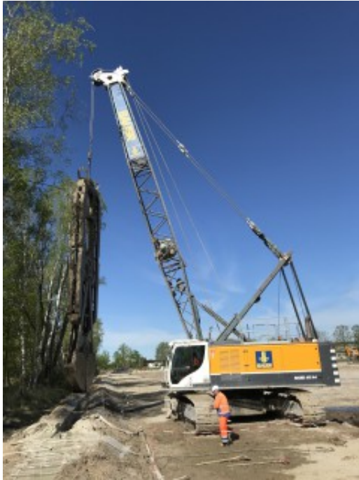
Erster Baggerbiss für Dichtwand an Südseite
