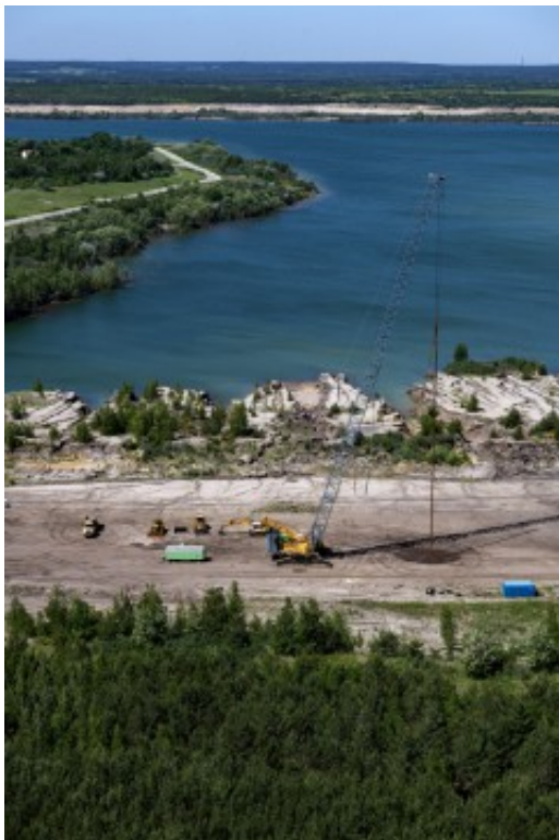
RDV-Technik am Restloch Greifenhain
