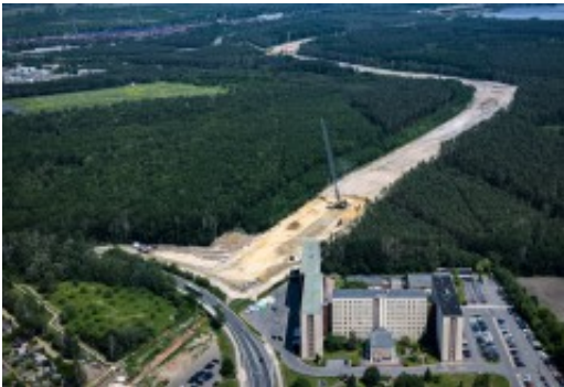
Künftige Ableitertrasse wird zuvor verdichtet
