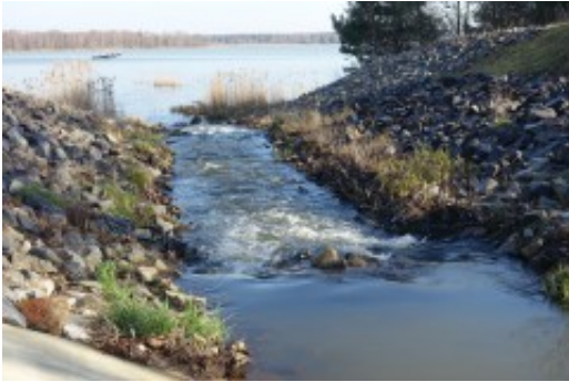
Flutungswasser aus der Kleinen Spree für das
