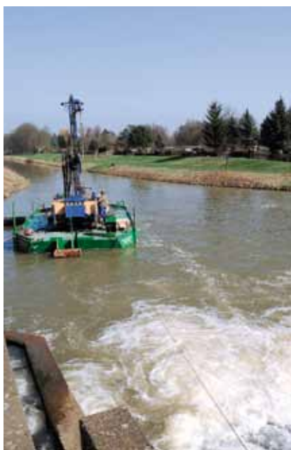
Bohrgerät für die Erkundungsbohrungen auf Ponton am Connewitzer Wehr in der Pleiße.
