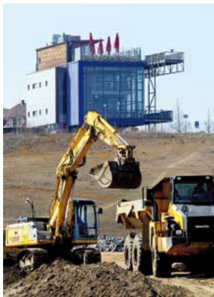
Letzte Erdarbeiten im Hafengebiet Zwenkau.
