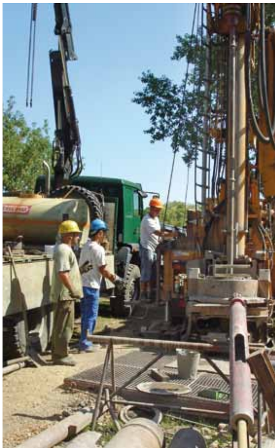
Bohrung zusätzlicher Pegel in Nachterstedt.
