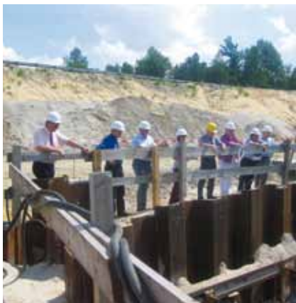
Mitglieder des regionalen Sanierungsbeirates an der Baugrube der Schleuse.
