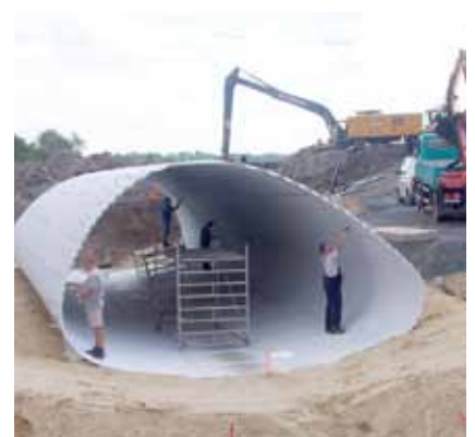
Bau der Röhre am Einlaufbauwerk in die Pleiße.
