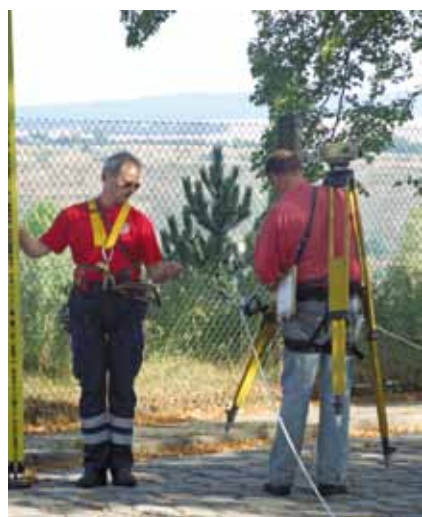
Geländevermessung in Nachterstedt.
