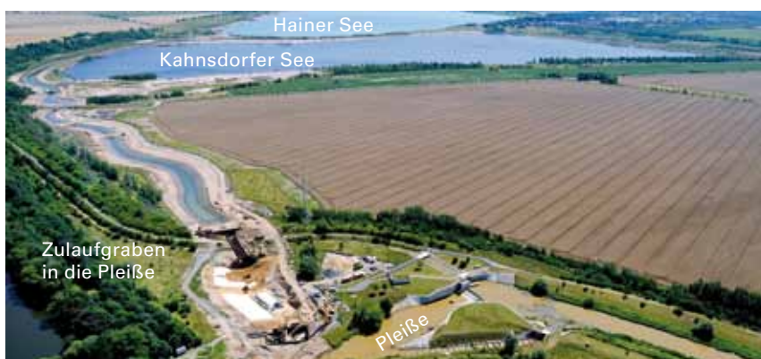
Im Vordergrund: Bau des Einlaufbauwerkes in die Pleiße.
