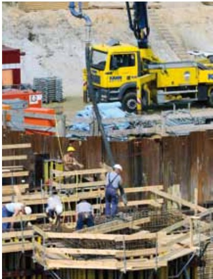
Die Schleusenwände werden betoniert.
