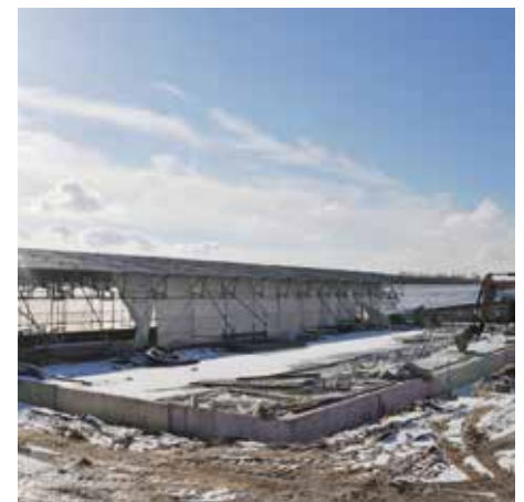
Die Bauarbeiten am Schleusenbauwerk des Koschener Kanals trotzten den winterlichen Wetterbedingungen. Im Vordergrund ist schon das Fundament des künftigen Schleusenwärterhauses zu sehen.
