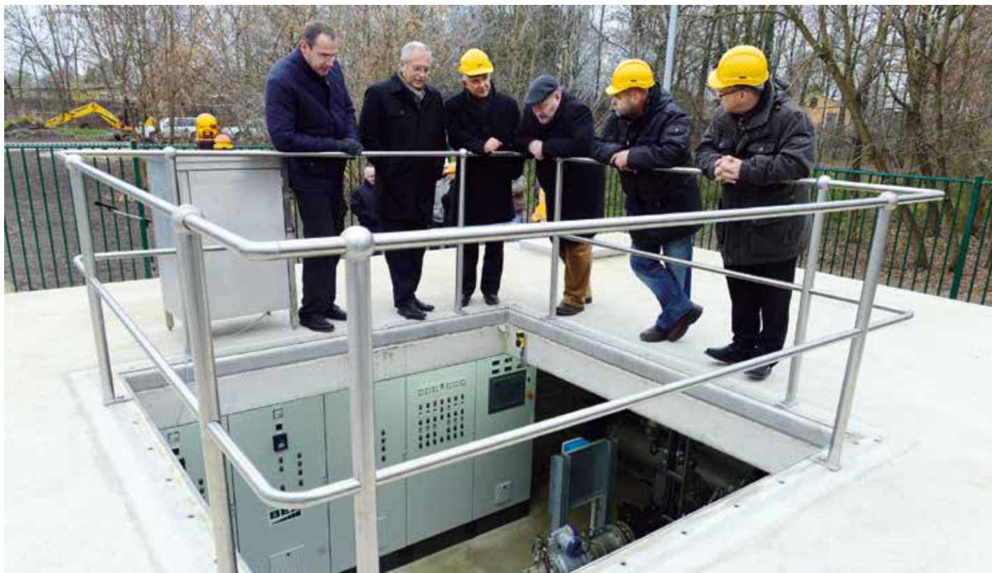
Bei Frost wurde im Beisein von Bürgermeister Andreas Fedrich (l.) und dem MIL-Vertreter Klaus-Otto Heymanns (4.v.l.) der Horizontalfilterbrunnen in der Senftenberger Badstraße termingerecht in Betrieb genommen.
