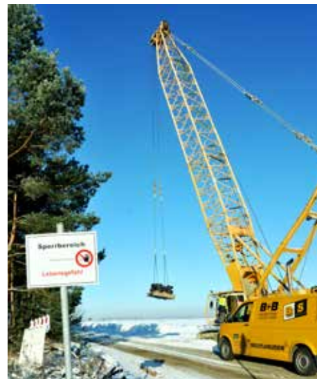
Trotz Schnee und Eis wurde bei Sedlitz mit der Fallplatte der gekippte Grund verdichtet.
