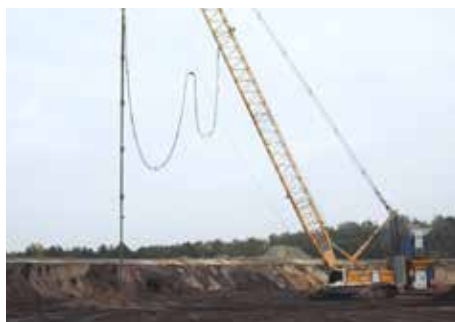
Die LMBV-Verdichtungsarbeiten im Tagebau Cottbus-Nord im dunstigen Januar-Winter 2016.
