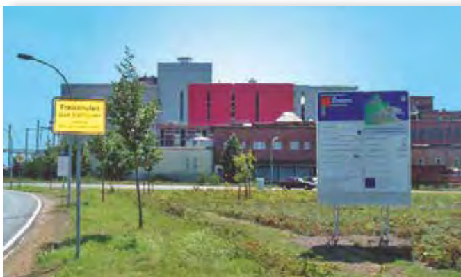
Einfahrt zum Industriepark
