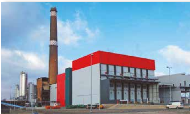
Neubau des Ersatzbrennstoffkraftwerkes
