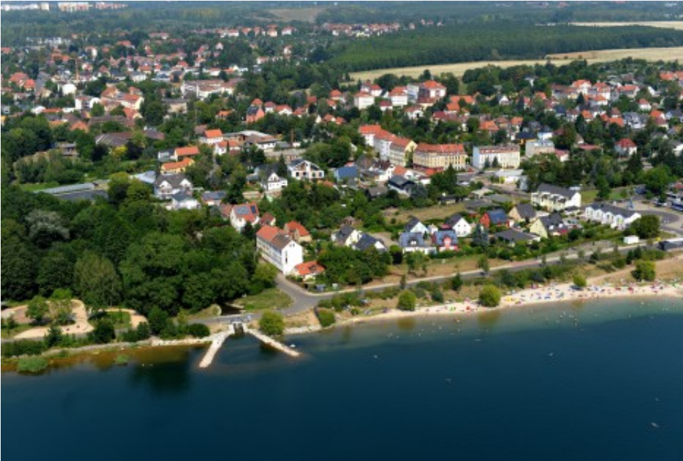
LMBV: Blick über das Auslaufbauwerk nach Markkleeberg 2015
