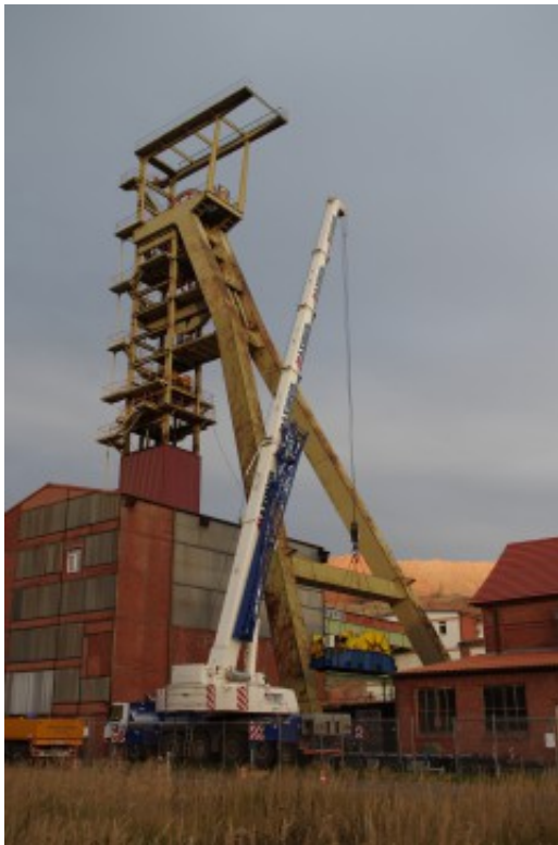
LMBV: Fördergerüst Bischofferode 2017
