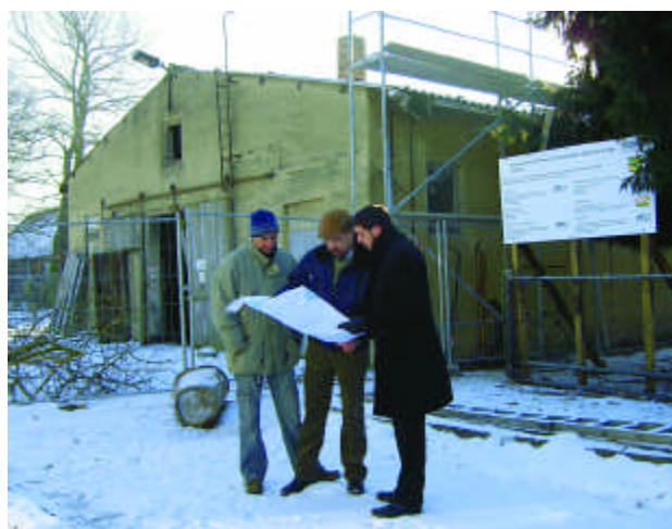
GlauCon-Bauleiter Karsten Dohrmann, LMBV-Projektmanager Uwe Zippel und Udo Witschas: Ende März soll die Sanierung beendet sein.
