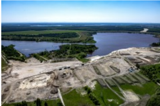
Sanierungsarbeiten Nordfeld Sedlitzer See (2018)
