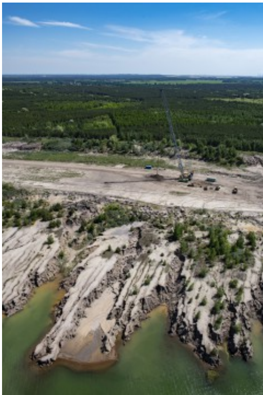
Verdichtungsarbeiten am Altdöberner See (2018)
